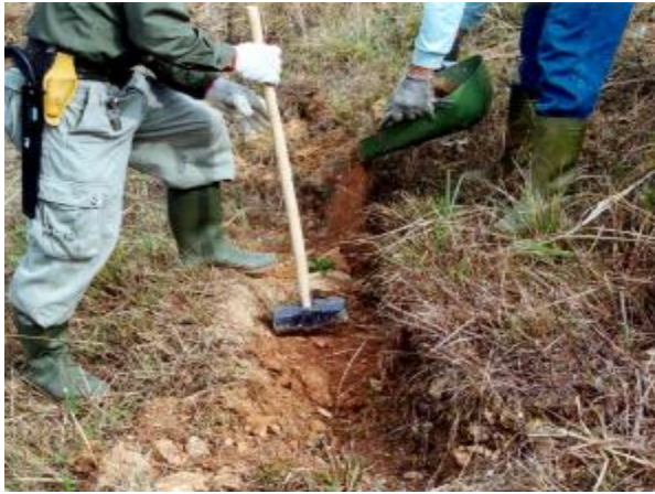
圖 5.7.8 裂縫填補施工照片
