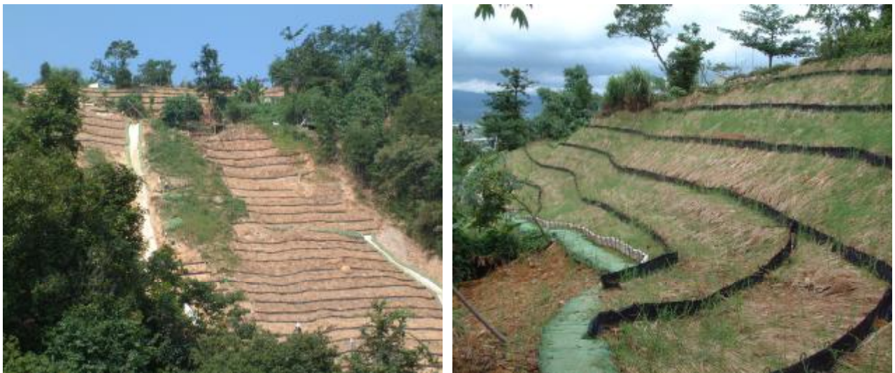
圖 5.7.18 裸坡面植生工法施工照片
