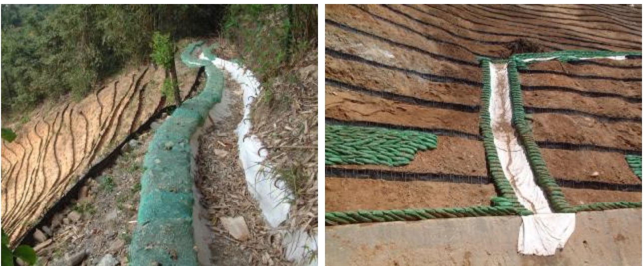
圖 5.7.16 蝕溝處理照片
