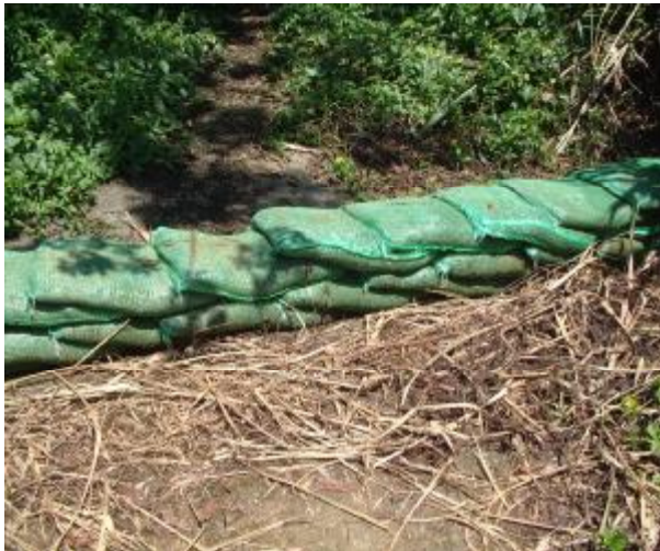
圖 5.7.14 客土包堆砌(左)與打樁編柵(右)照片
