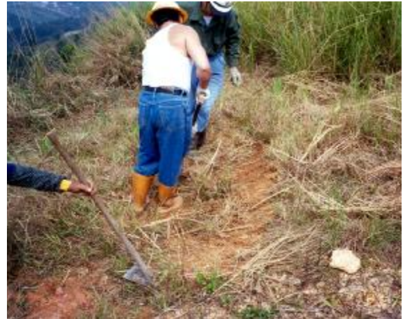
圖 5.7.8 裂縫填補施工照片
