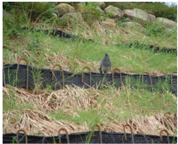
圖 5.7.14 客土包堆砌(左)與打樁編柵(右)照片
