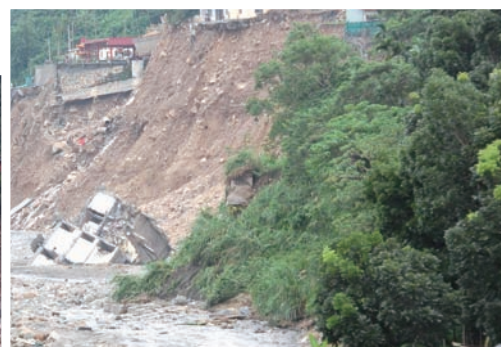
路基嚴重掏空導致房屋倒塌
