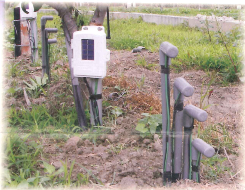
土壤水分計田間安裝情形
