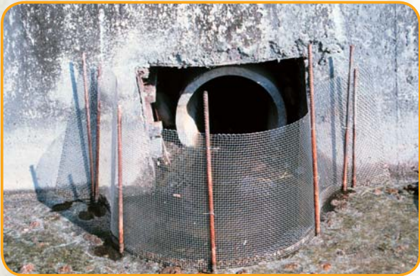
進水口裝置鐵絲網阻絕福壽螺侵入
