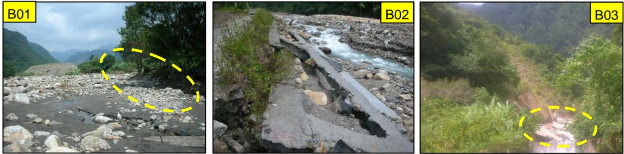
(三)路基沖刷：因位於凹岸處道路下邊坡受河水沖刷、護岸保護不足或道路排水不良，造成道路損毀，建議可施設護岸或道路側溝排水。
