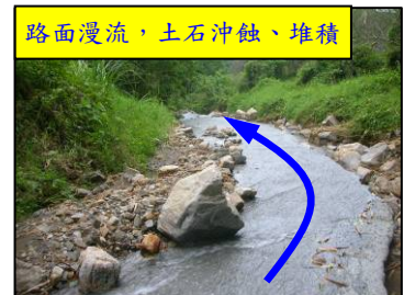
(6)坑溝06：現況河寬約3m、深度約1.5m，蝕溝寬原為20-30cm，卡玫基颱風後上游邊坡崩塌大量土砂下移、沖蝕擴大，平均縱坡30%，平均粒徑30-40cm，中游流路不穩定造成道路基礎淘空，土砂下移堆置於路面上，下游銜接野溪處無施設工程構造物，蝕溝長約700m。由於坑溝流路不明且土砂下移狀況嚴重，且下游右岸有一住戶保全對象，規
