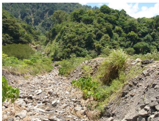
P14-野溪 07 土石堆積河道
