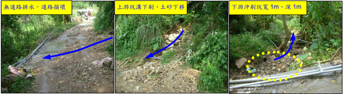
(4)坑溝04：上游溝渠底部為天然岩盤，溝寬約2m，深度約1.5m，平均坡度30%，上游土砂下移輕微淤積於道路側，原既設過水涵管( \phi 60cm)堵塞，無法順利排放逕流，導致下邊坡沖刷加劇。
