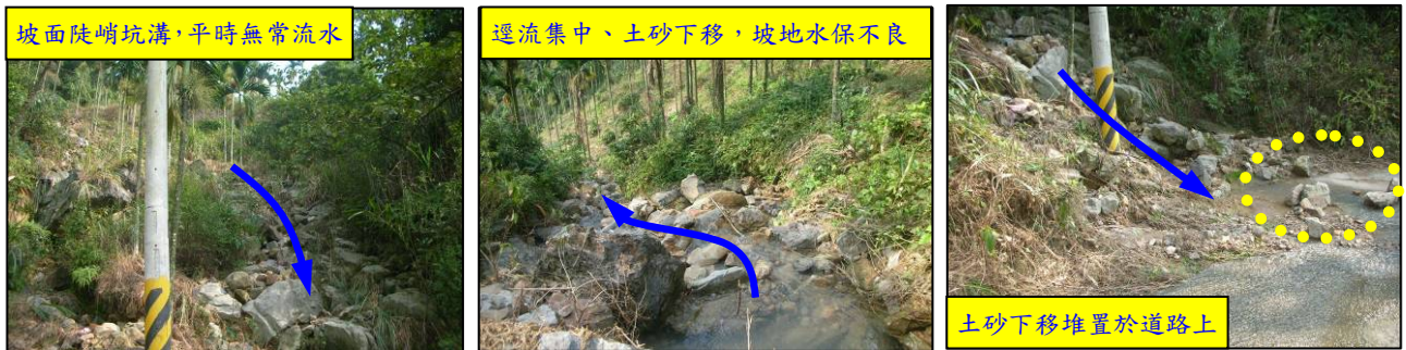
(6)坑溝06：現況河寬約3m、深度約1.5m，蝕溝寬原為20-30cm，卡玫基颱風後上游邊坡崩塌大量土砂下移、沖蝕擴大，平均縱坡30%，平均粒徑30-40cm，中游流路不穩定造成道路基礎淘空，土砂下移堆置於路面上，下游銜接野溪處無施設工程構造物，蝕溝長約700m。由於坑溝流路不明且土砂下移狀況嚴重，且下游右岸有一住戶保全對象，規
