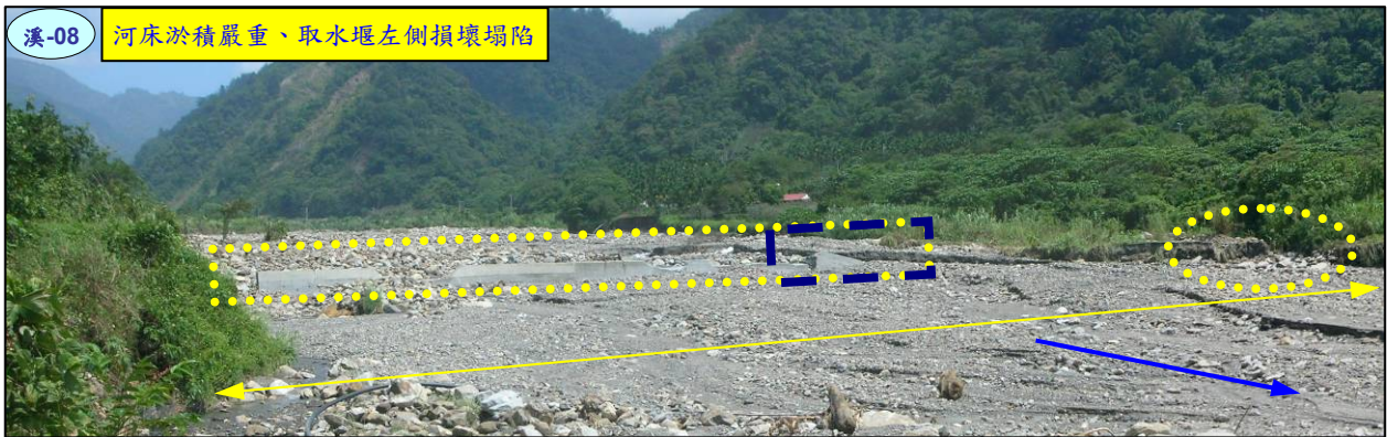
溪-08 取水圳左岸因取水口損壞喪失
