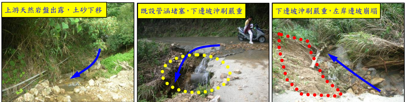
(4)坑溝04：上游溝渠底部為天然岩盤，溝寬約2m，深度約1.5m，平均坡度30%，上游土砂下移輕微淤積於道路側，原既設過水涵管( \phi 60cm)堵塞，無法順利排放逕流，導致下邊坡沖刷加劇。
