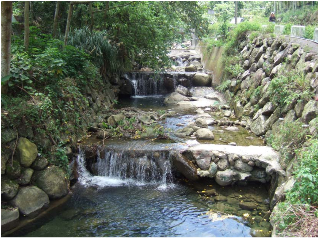
圖 6-1-30 科角溪山腳二號橋下游河段
