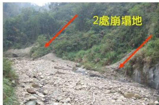
金瓜坑一號橋上游梳子壩基礎下切及左岸 2 處崩塌情形
