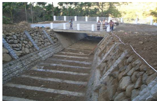
圖 7.7 連續式固床工示意圖
