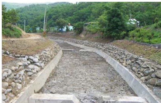
圖 7.12 整流工程-開口式固床工示意圖
