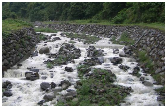
圖 7.7 連續式固床工示意圖
