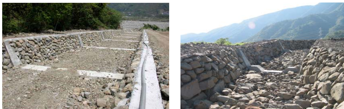
圖 7.10 砌石護岸示意圖
