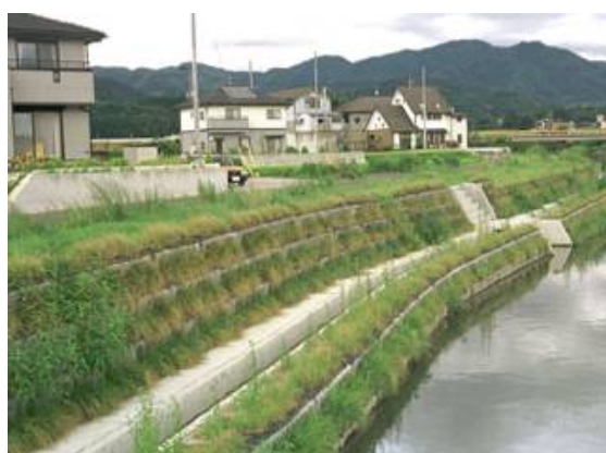
圖 7.16 預鑄槽框式植生護岸示意圖
