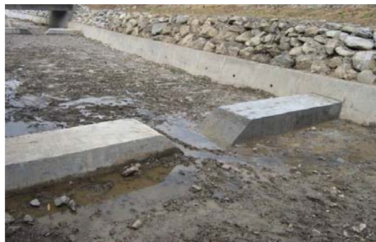
圖 7.12 整流工程-開口式固床工示意圖
