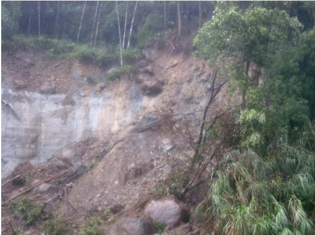
圖 3-3 土石崩落坡面土石崩落仍持續發生(2009/10/02)
