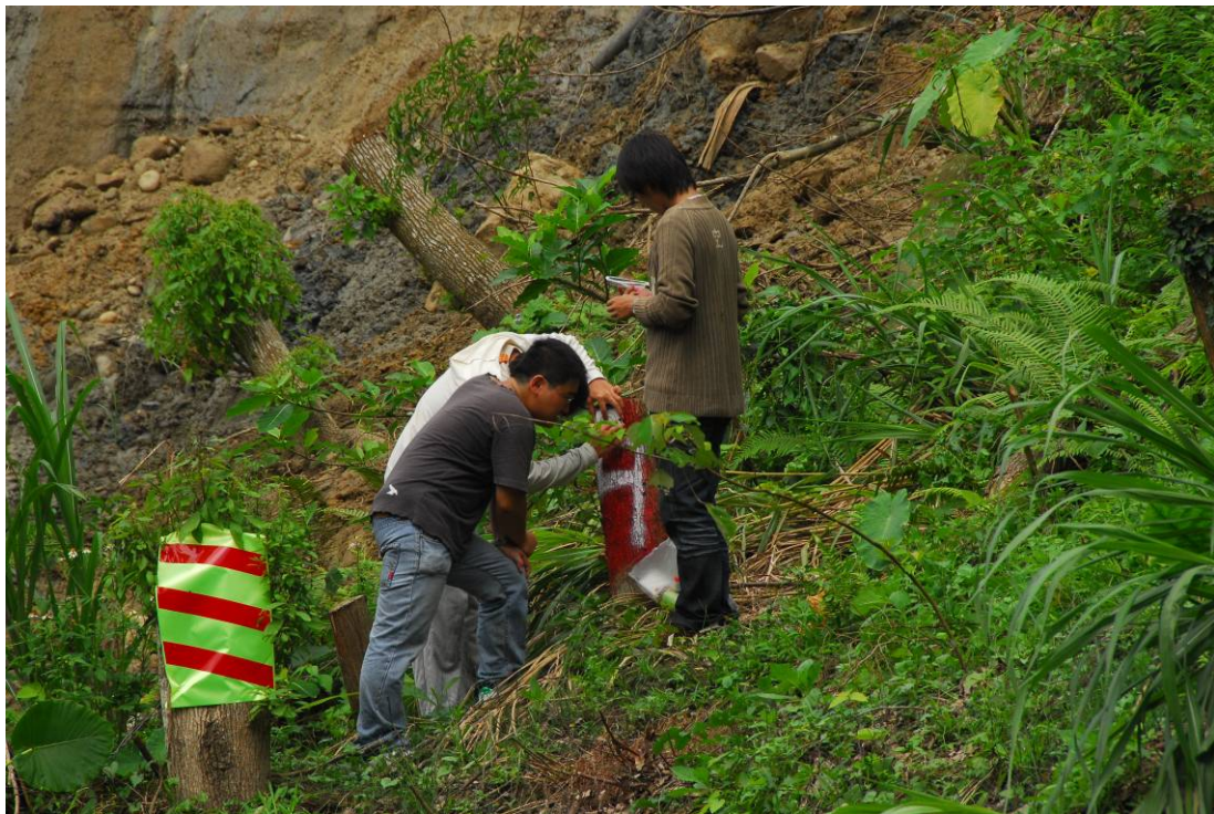
圖 5-3 現地反光覘標貼設情形
