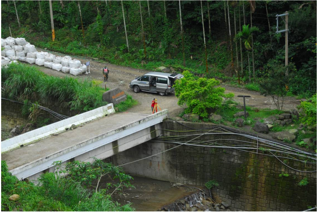
圖 5-4 現地 TOPCON 觀測情形
