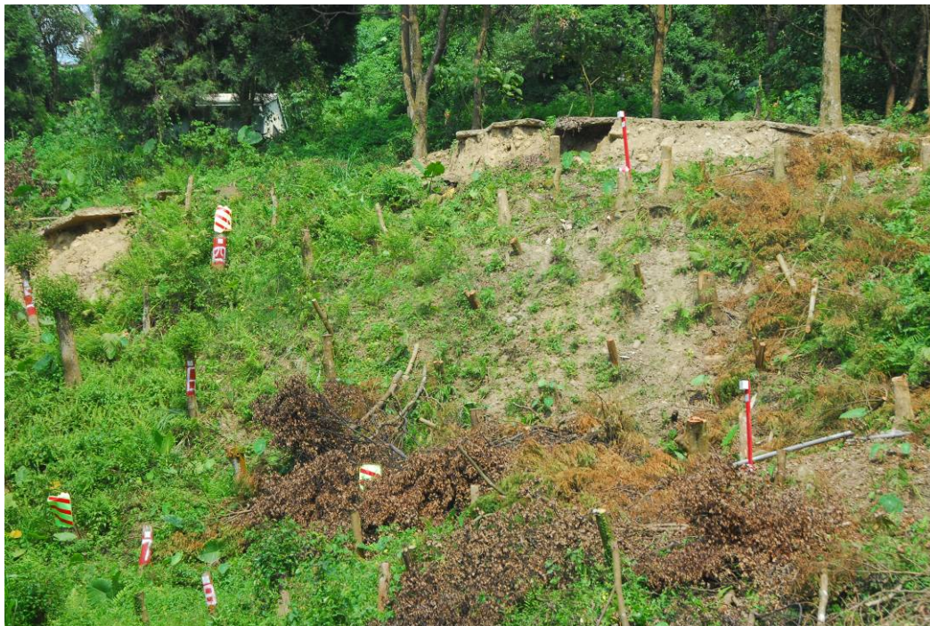
圖 6-5 設置伸縮或傾斜警示的裝置一
