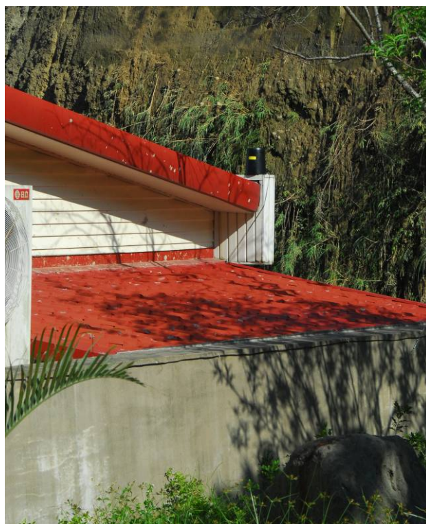
圖 6-8 現場自記式雨量計裝置
