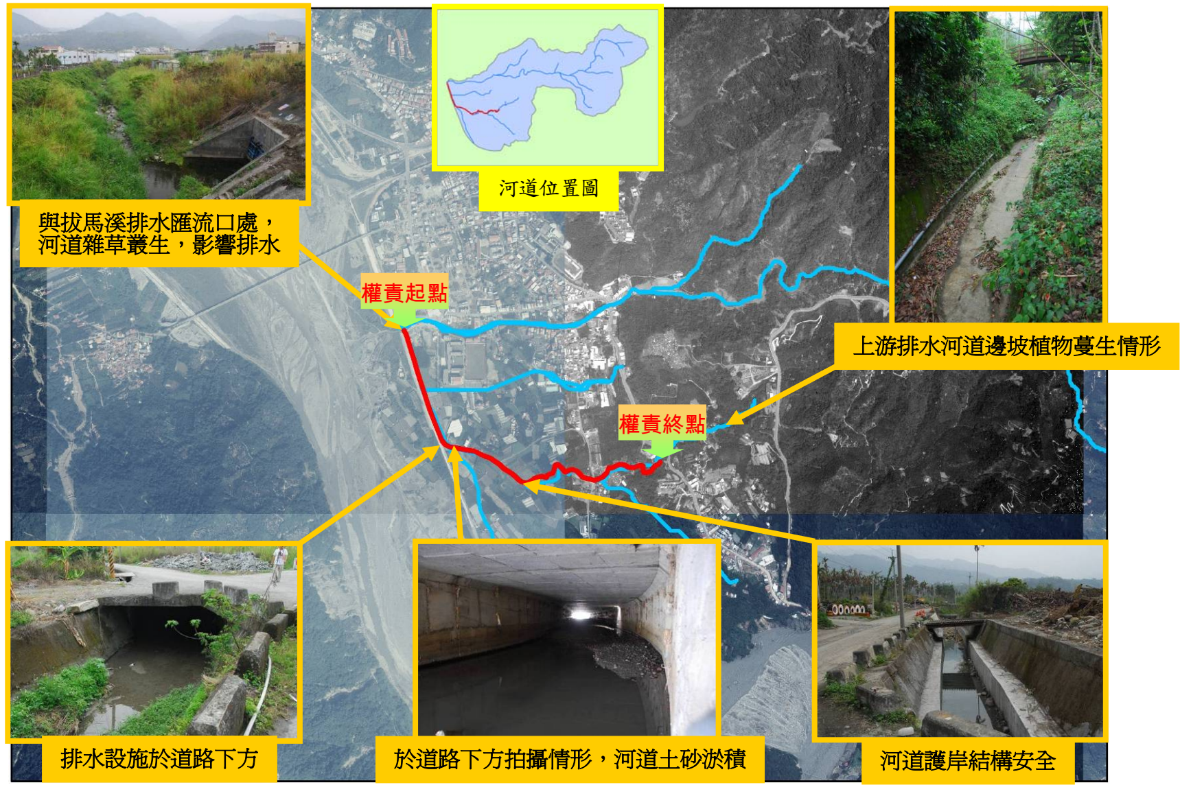
圖3-5-10 拔馬溪支流一現況說明及現勘照片
