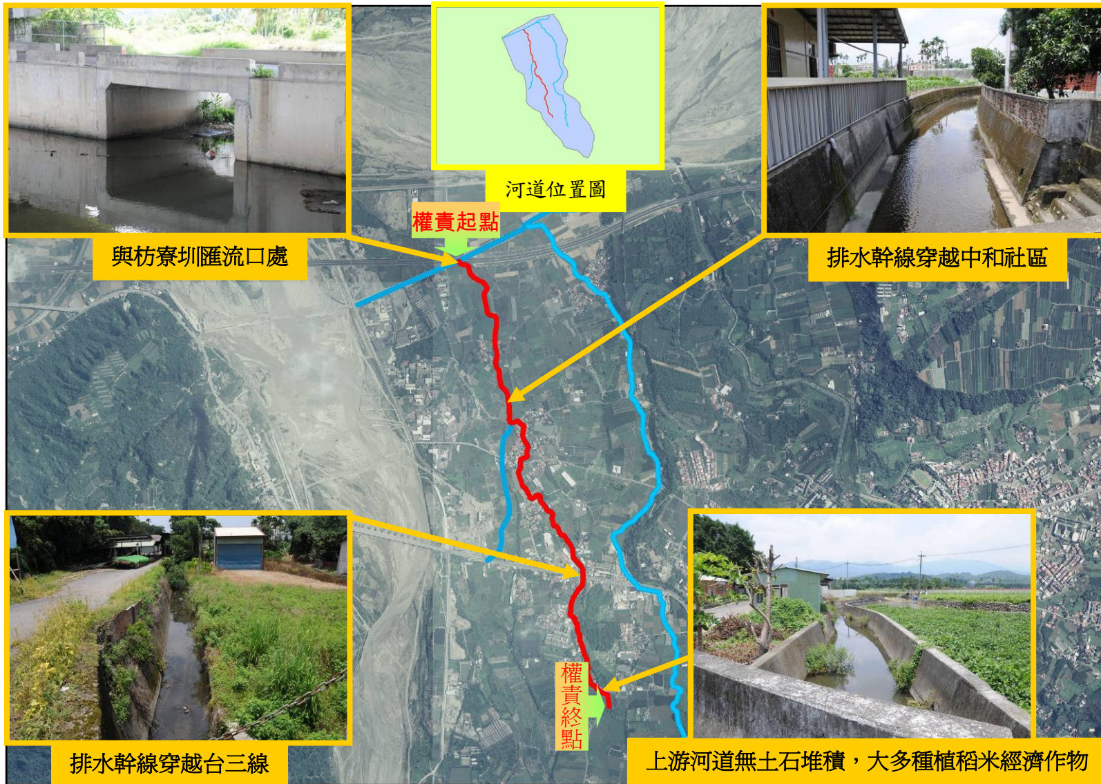
圖3-5-21 冷水坑排水幹線現況說明及現勘照片
