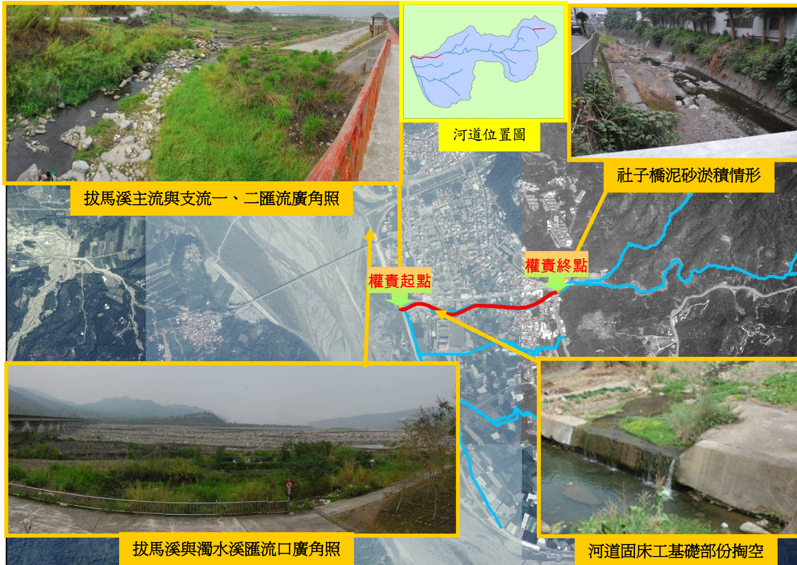
圖3-5-9 拔馬溪排水現況說明及現勘照片
