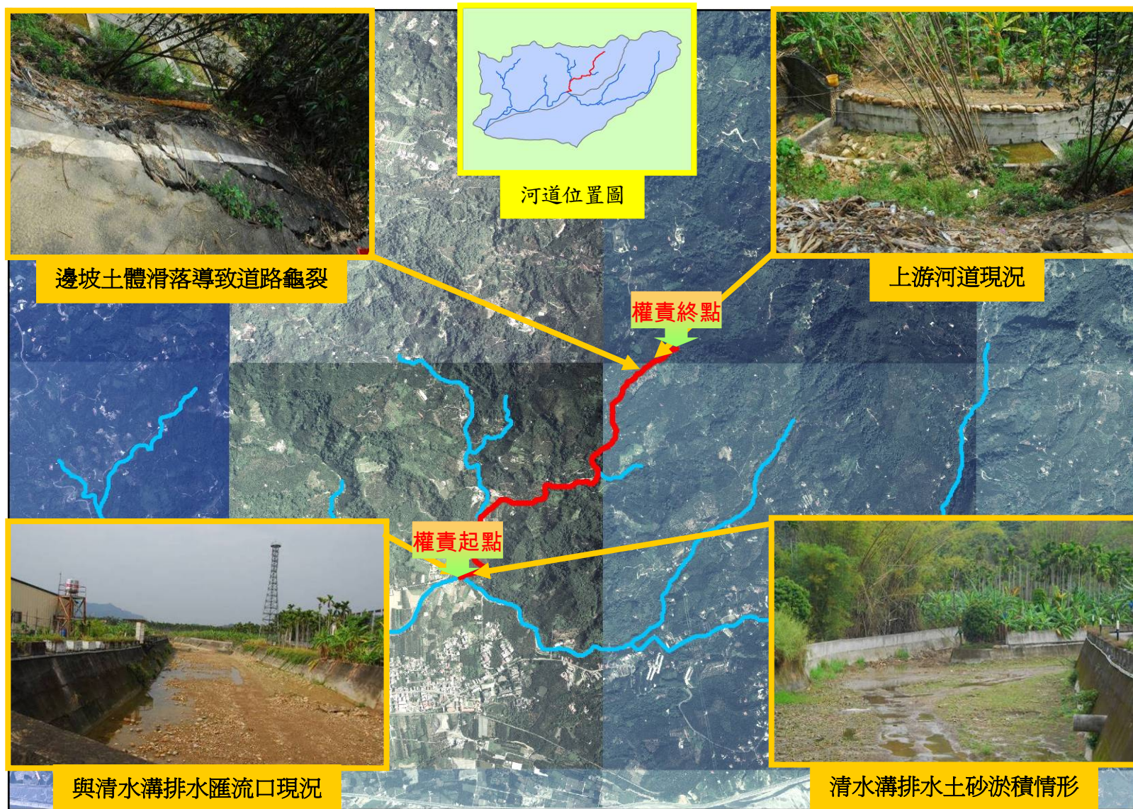
圖3-5-14 北勢溪排水現況說明及現勘照片
