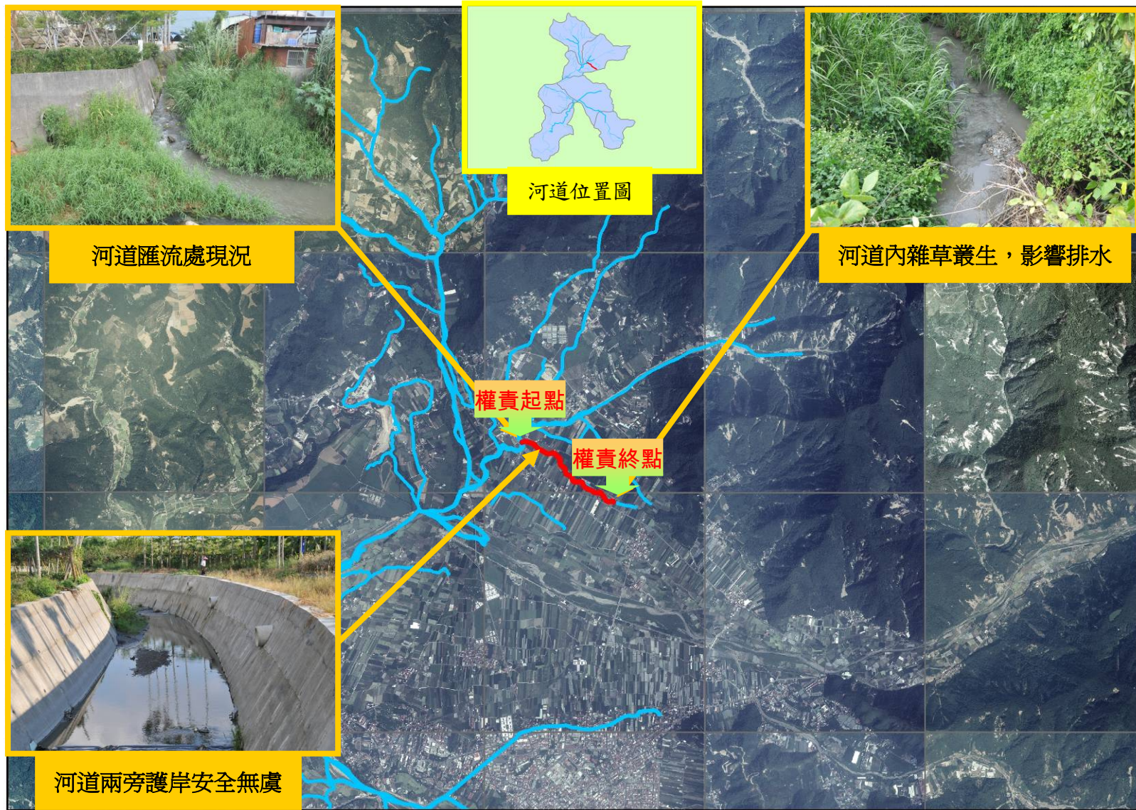
圖 3-5-27 大坑排水分線現況說明及現勘
