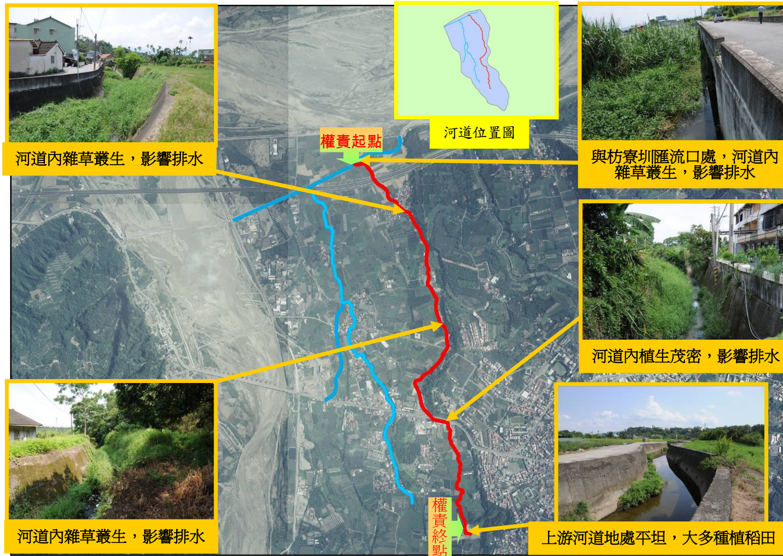
圖3-5-20 崎腳排水幹線現況說明及現勘照片
