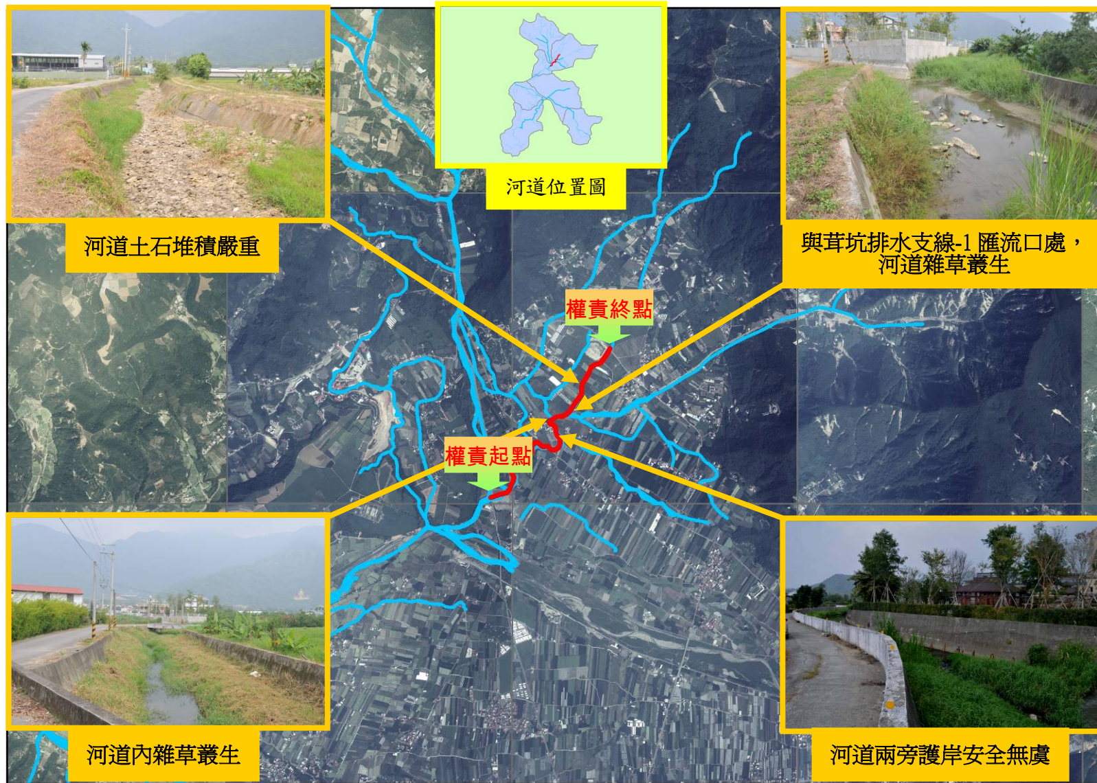
圖 3-5-25 茸坑排水支線現況說明及現勘照片
