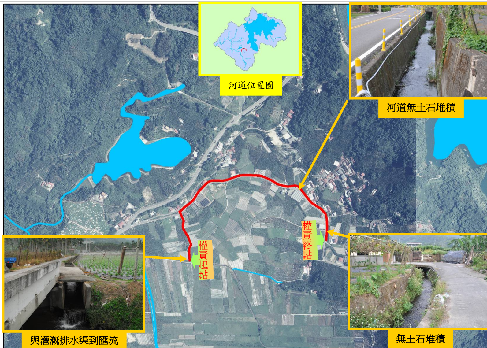
圖3-5-53 水尾溪排水幹線-5現況說明及現勘照片
