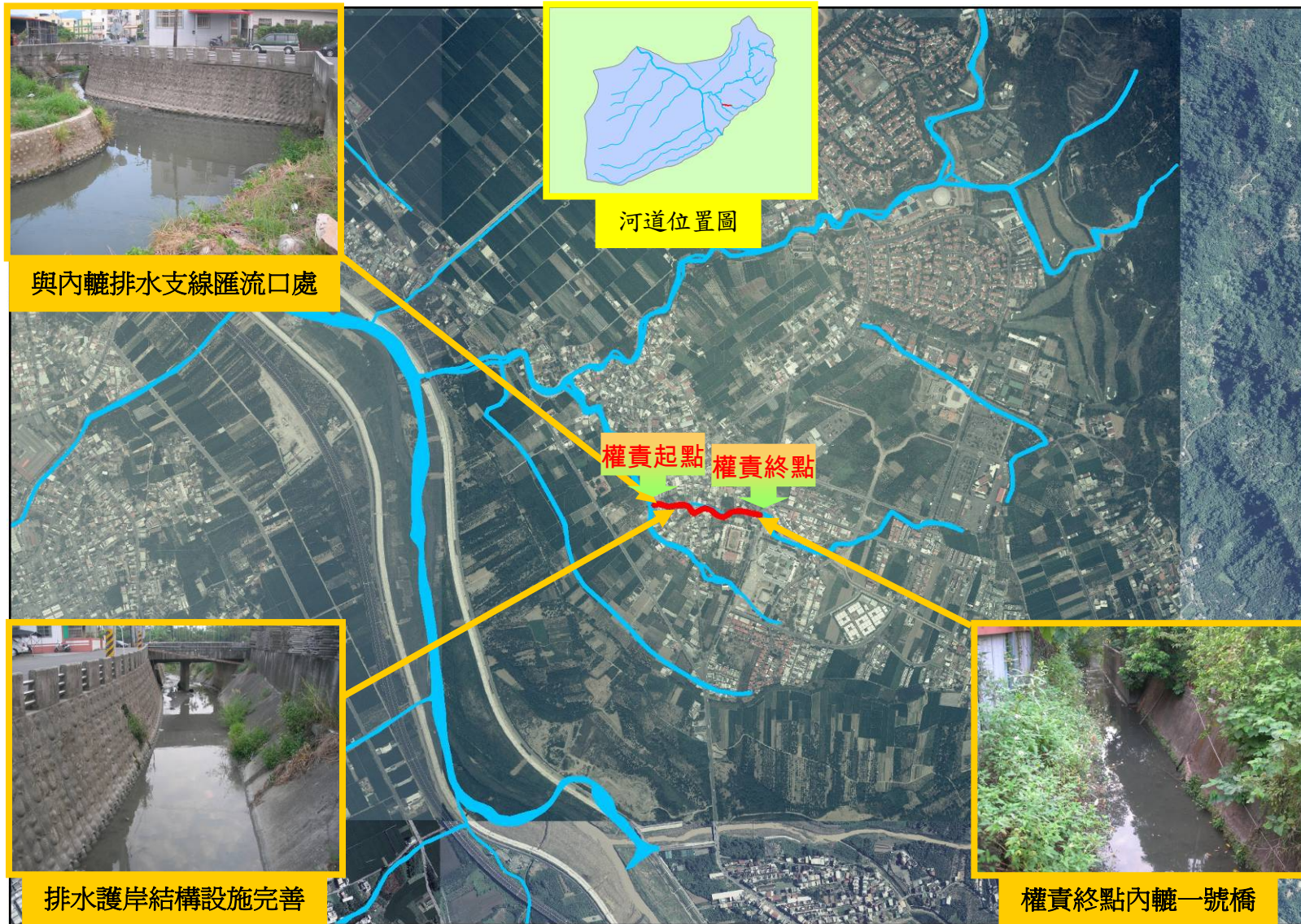
圖3-5-34 內轆排水幹線-1現況說明及現勘照片
