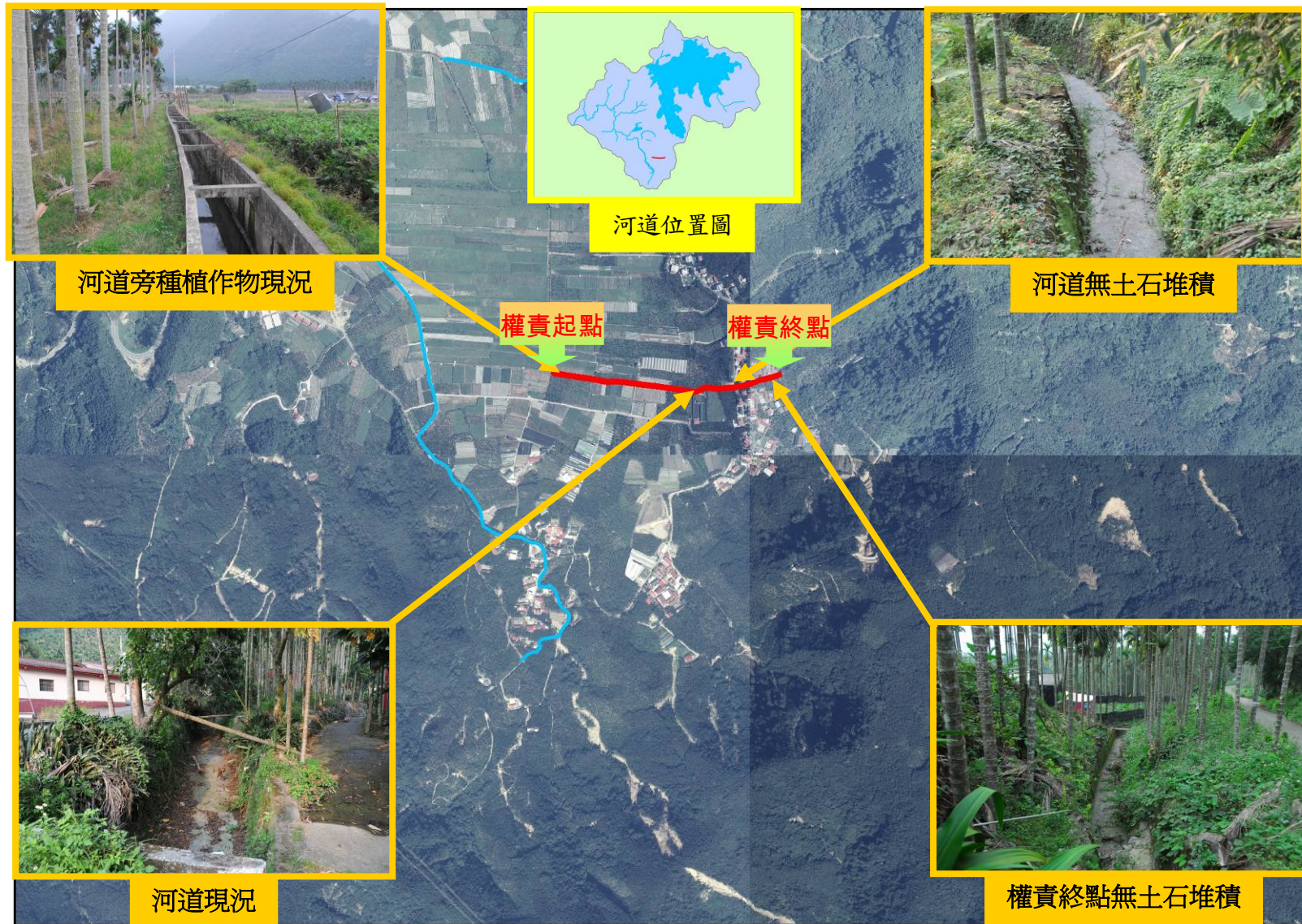
圖3-5-51 水尾溪排水幹線-2現況說明及現勘照片
