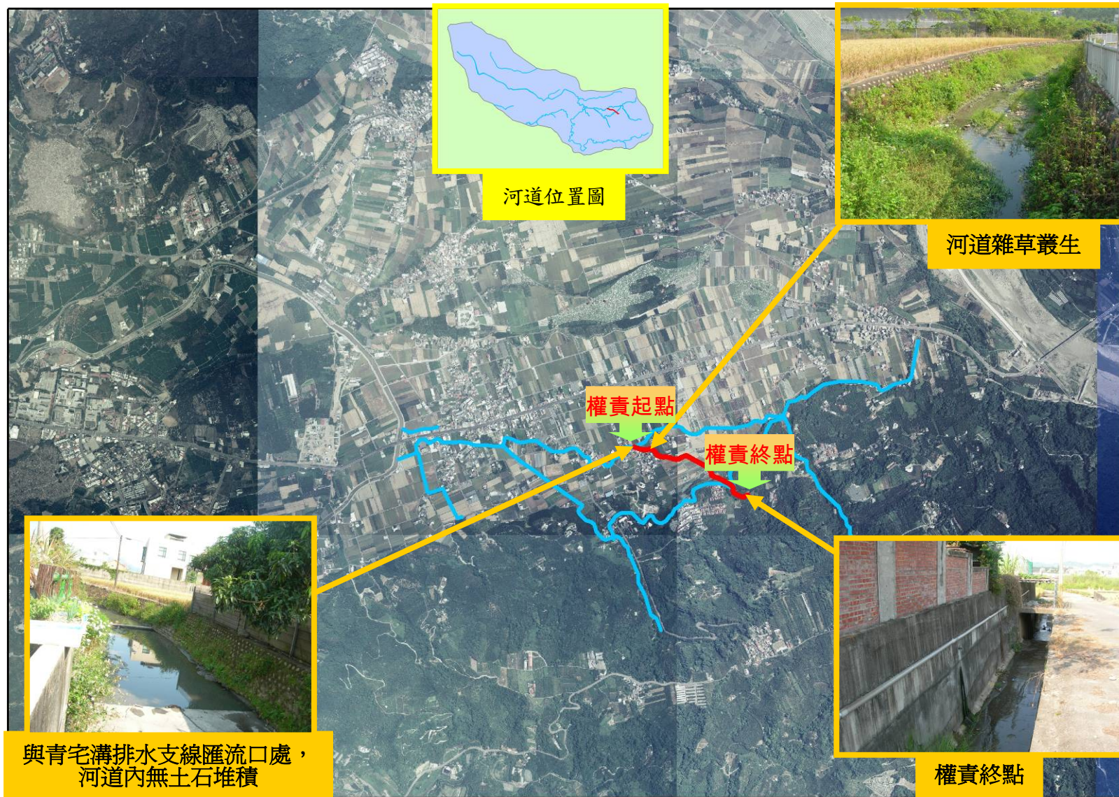
圖3-5-37 青宅溝排水分線現況說明及現勘照片
