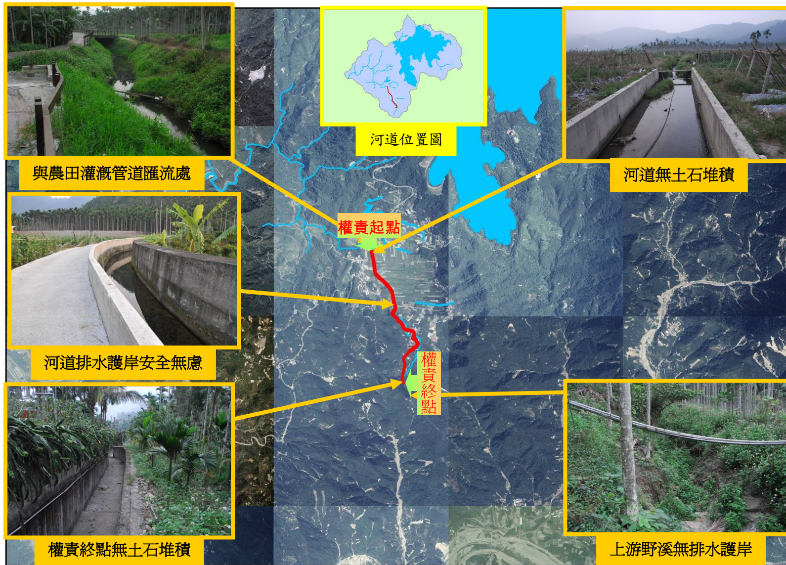
圖3-5-50 水尾溪排水幹線-1現況說明及現勘照片
