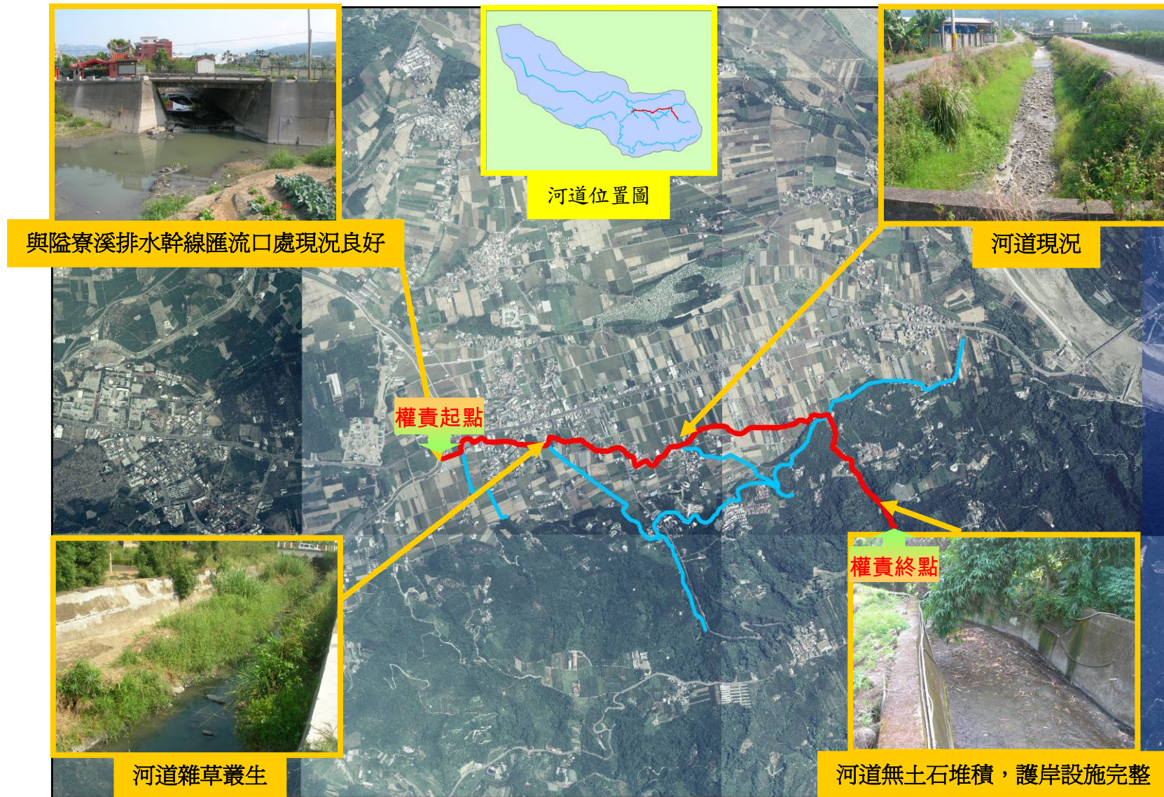
圖3-5-36 青宅溝排水支線現況說明及現勘照片
