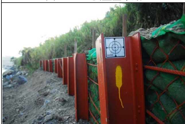
圖3-3-18 反光規標於H型鋼架設
