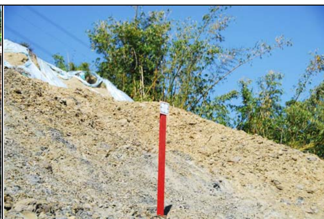
圖3-3-17 反光規標於坡地架設
