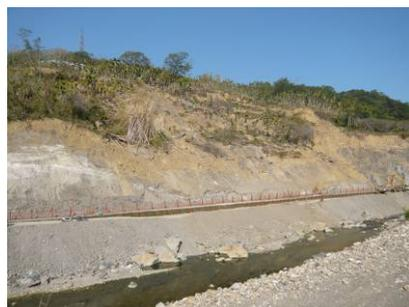
此外於莫拉克風災後，爲避免副側線邊坡坡趾凹岸處受水長流溪持續淘刷，造成基腳流失，進而發生邊坡滑落情形，水土保持局南投分局立即於坡趾處進行2件災害復建工程，首先爲「大旗崩塌地災害復建工程」，工程內容包含：縱向A1、A2主拍漿溝共計312m、A1、A2拍漿支溝共計539m、HDPE暗溝143m、集水井2座、RCP管6支、矩形溝5m及長15m排樁80支等，已於99年1月10日開工，預計於99年12月15日完工，其次爲「大旗崩塌地災害復建第二期工程」，工程內容包含：排樁工程共計106支，帽樑共148m，護岸工程153.5m，固床工2座，噴漿溝300m，厚層噴植1,400m<sup>2</sup>及臨時性防災措施等，相關配置詳圖4-3-15~4-3-17所示。
