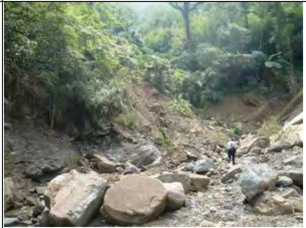
出口左岸邊坡遭切割
