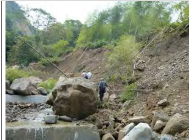
護岸及固床工上巨石
