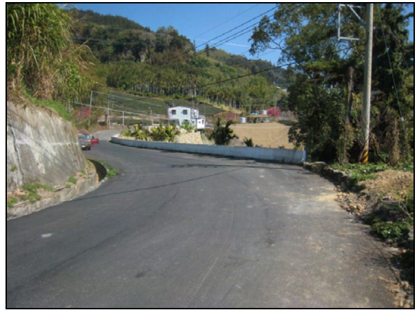
(2)莫拉克颱風前邊坡現況(98/2/3)
