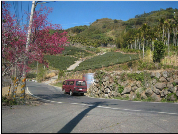
(1)莫拉克颱風前邊坡現況(98/2/3)
