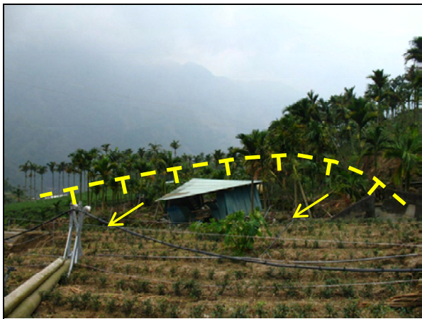
(3)莫拉克颱風後崩崖陷落(98/8/24)
