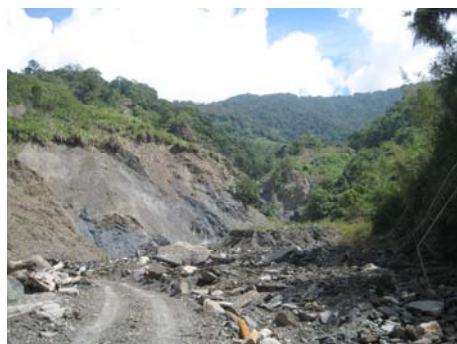
照片 3-6 合望溪野溪淤積情形 (左一子集水區)
