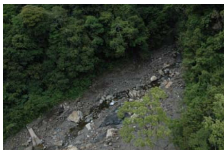
照片 3-5 合望溪野溪淤積情形 (右一子集水區)
