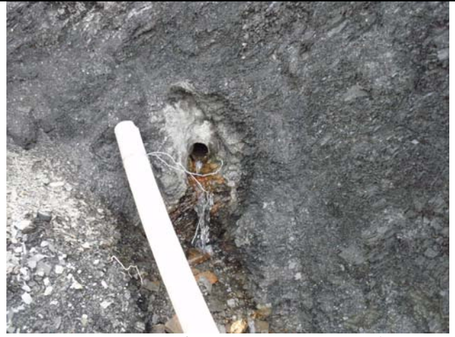
照片四 裸露坡面的導水孔排水情形，顯示崩塌坡體內之地下位豐富。
