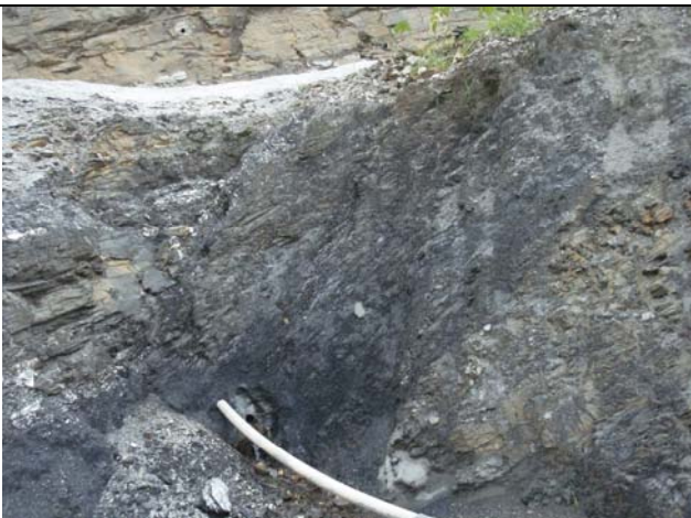
照片三 灰黑色處為斷層錯動過剪裂破碎帶及剪裂泥，可能為眉溪斷層通過處。
