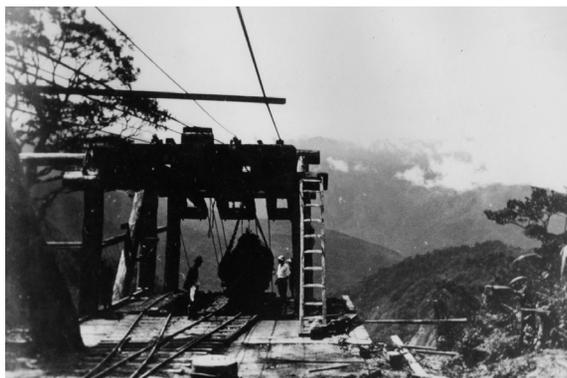
▲照片12 架空索道（是當時太平山運材設備兼員工交通工具之一，曾造就太平山獨特風貌，當時建造費用為28,000日圓。此為鳩之澤索道起點，全長1公里，高低差399公尺，標準載重量5噸。運作原理是利用木材本身重量，由架設之鋼索調掛後向下滑走，並用引索轉入制動機控制其衝力，啟動後不到5分鐘即可達着點）。
