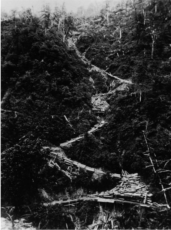
▲照片3 修羅集材（原木利用滑道滑向止擋場，再由軌道旁的台車裝材，準備運出。滑道分土滑道與木滑道，又稱為修羅）。
