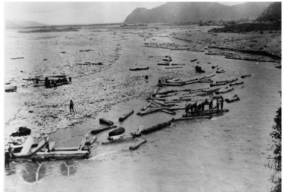
▲照片6 管流運材（1916-1923年，濁水溪管流運材，運費低廉但容易破損，若原木擱淺，則須以人力執長桿尖嘴杵導向）。
