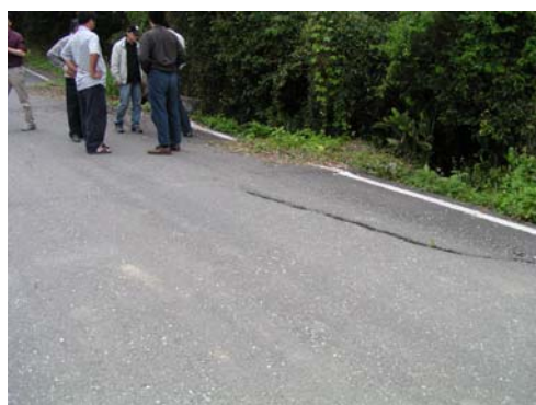
《羅山產道下坡坎下陷》 螺仔溪上游： (X=277877 Y= 2564949)
