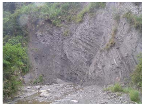
《錦水橋兩岸邊坡土石崩落，呈淤積現象》 富源溪：安夜西溪上游 (X=292302 Y= 2604110)
