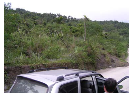
《地滑地檳榔樹下滑傾斜、土方崩落》 安通溪上游： (X=285125 Y= 2575684)
