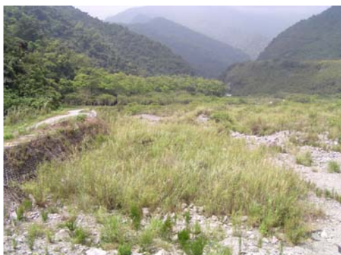
《必勇橋右岸無護岸待新設》秀姑巒溪上游： 崙天溪上游 (X=273948 Y= 2568628)
