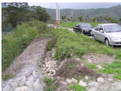
《池豐產道下坡坎下陷》 鯢溪上游： (X=276494 Y= 2561707)
