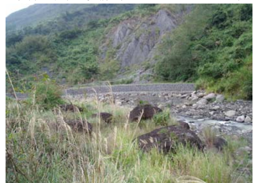
《邊坡裸露》 九岸溪：(X=280577 Y= 2567596)
