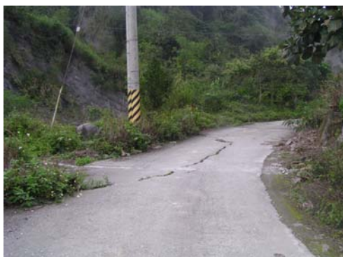
《下方土石冲刷致使上層農路下陷》 富源溪：安夜西溪上游 (X=292160 Y= 2604008)
