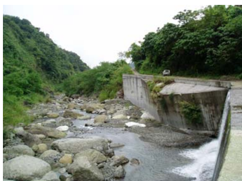
《護岸斷裂傾斜》 苓雅溪： (X=291391 Y= 2595620)
