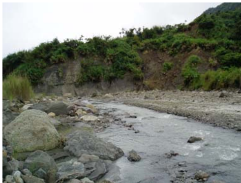
《攻擊岸掏刷，邊坡裸露》 樂合溪：(X=286448 Y= 2580136)
