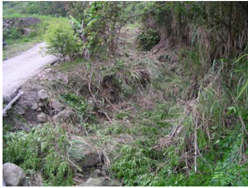
《未施設護岸道路待保全》 九岸溪支流野溪： (X=279848 Y= 2566747)
