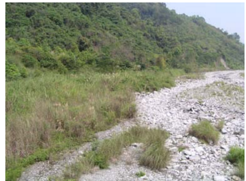
《左岸無護岸，有三戶民宅保護》 卓溪：中平一號橋 (X=280234 Y= 2587921)
