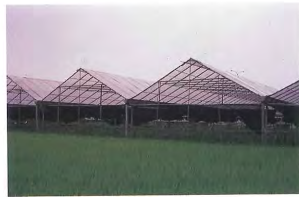
圖4. A字型連棟溫室，屋頂較高，不易熱累積。
