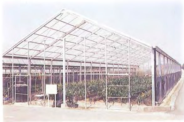
圖2. 較高的設施較不易發生熱累積，而影響作物之生育。
