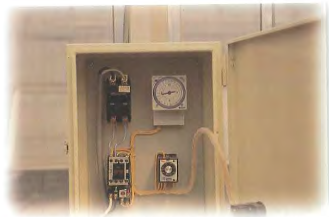
圖14. 配合時間控制器可定時定量噴施水分，工作時間很具彈性。
