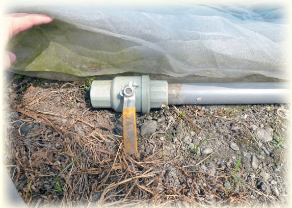
▲圖10. 供水管路末端必須可以排水。
