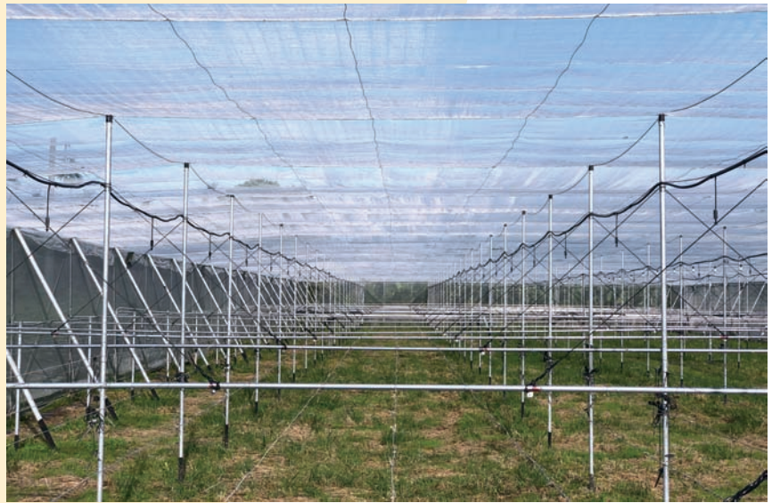
圖13. 利用軟鋼索懸吊支撐二層棚鋁管主線
