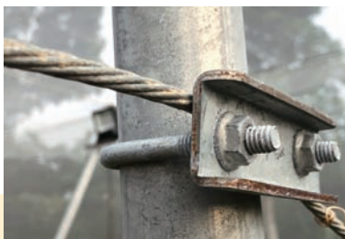
圖11. 利用U形零件固定鋼索，可避免攻牙釘破壞鋁管。
