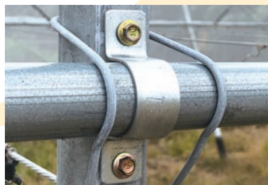
圖12. 將白鐵歐姆夾用自攻牙釘固定在立柱鋁管上
