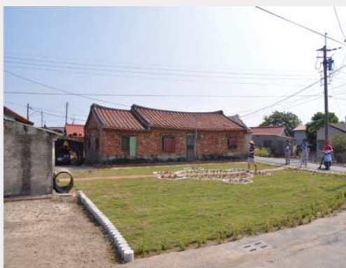
完工後社區又增加一處休憩空間
