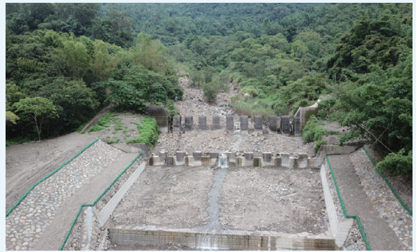
▲ 和南巷野溪（高市 DF071）災害復建四期工程（高雄市甲仙區）
