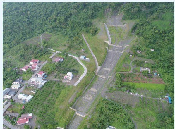
▲ 紅葉紅谷橋野溪復建工程（臺東縣延平鄉）
