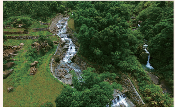
▲ 粗坑溪上游野溪整治工程 (南投縣中寮鄉)
