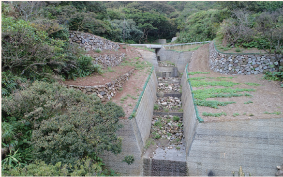
▲ DF218 土石流潛勢溪流災害復建工程（新北市金山區）
