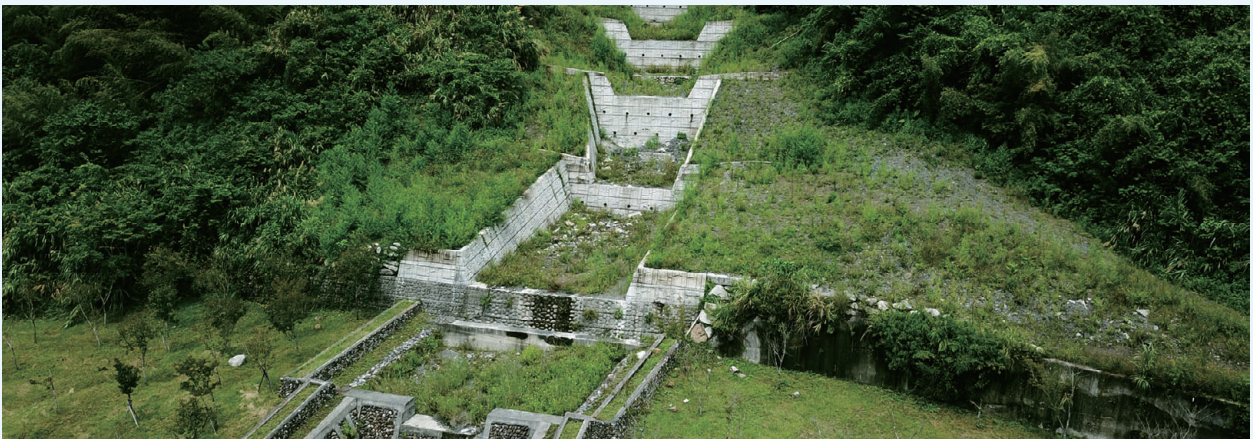
▲ 臺7線89K+150道路上邊坡坑溝治理工程（宜蘭縣大同鄉）
