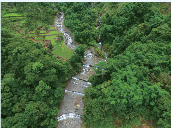
▲ 粗坑溪上游野溪整治工程（南投縣中寮鄉）
