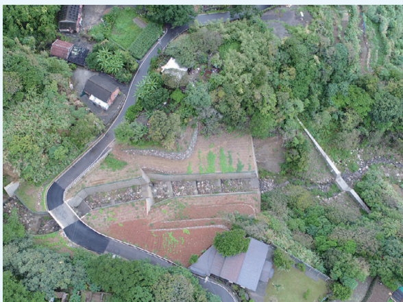
▲ 新北 DF218 土石流潛勢溪流災害復建工程 (新北市金山區)
