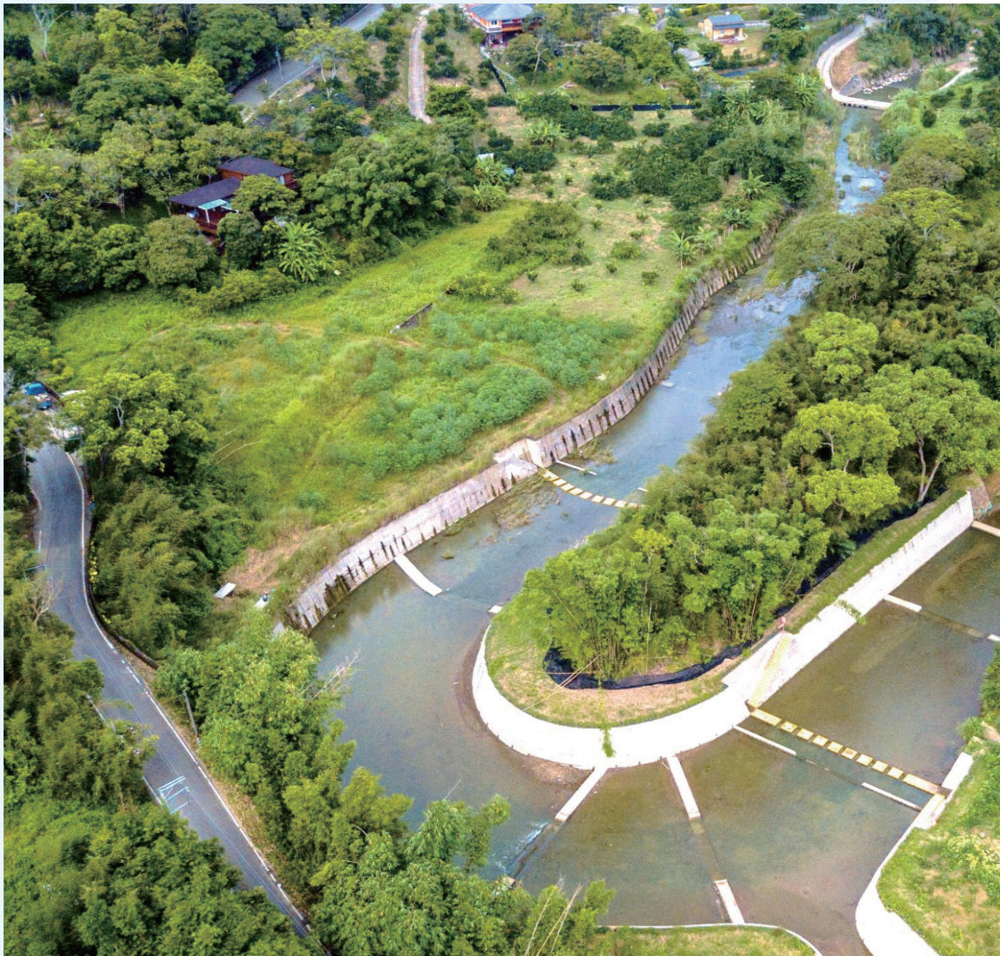
▲ 三灣大河底野溪整治三期工程（苗栗縣三灣鄉）
