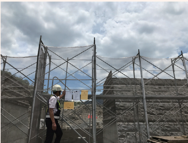
▲北坑溪(北田路 310 號段)護岸三期工程 - 採用 CNS4750 施工架，確保勞工高處作業安全（臺中市太平區）
