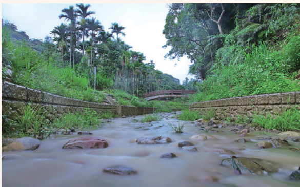
▲ 牛欄河支流柯仔崎橋上游野溪治理工程 (桃園市龍潭區)
