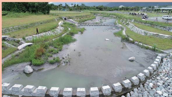
▲ 麗太溪東富田橋上游整治工程
