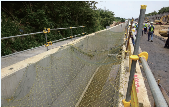
▲ 水土保持計畫施工訪查 - 西濱快速公路 WH10-C 標 64K+005 ~ 69K+600 主線新建工程
