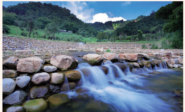
▲ 水流東溪 4K+380 支流整治工程 (南投縣埔里鎮)
