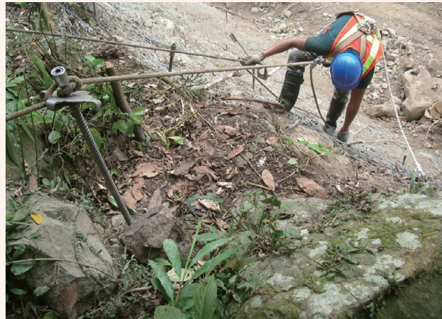
▲華興野溪及崩場地整治工程 - 邊坡作業採雙母索，保全作業人員安全（嘉義縣梅山鄉）
