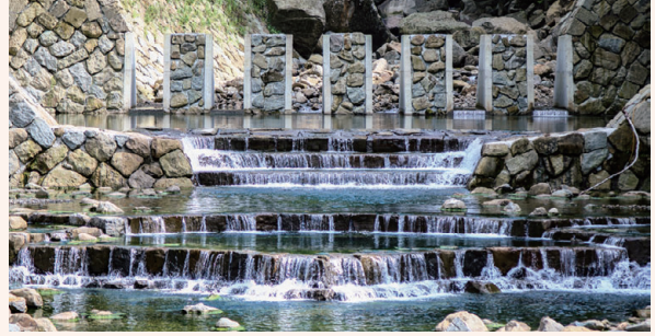
▲ 東西坑溪崩塌地及野溪治理七期工程 (嘉義縣大埔鄉)
