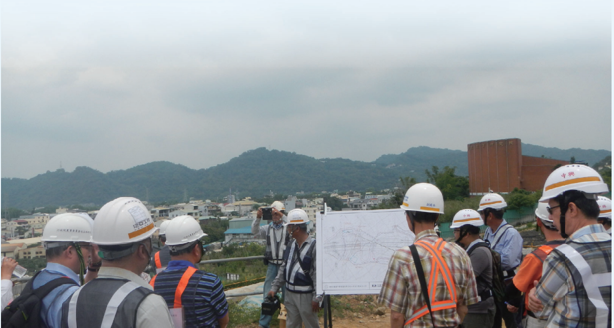
▲ 水土保持計畫施工訪查 - 國道 4 號臺中環線豐原潭子段 C712 標
