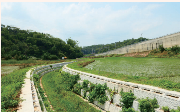
▲ 深井村楓樹窩坑溝整治三期工程（新竹縣寶山鄉）
