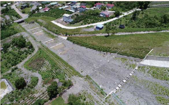
▲ 紅葉紅谷橋野溪復建工程（臺東縣延平鄉）
