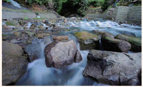
▲ 二櫃溪上游野溪整治工程 (臺中市新社區)
