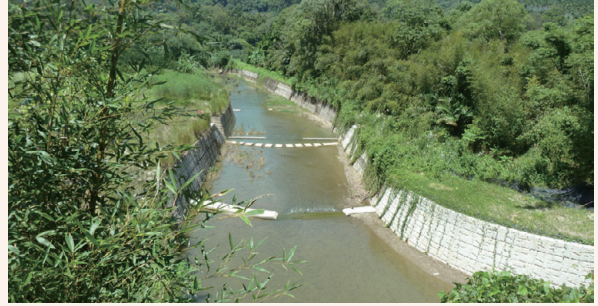
▲ 三灣大河底野溪整治三期工程 (苗栗縣三灣鄉)
