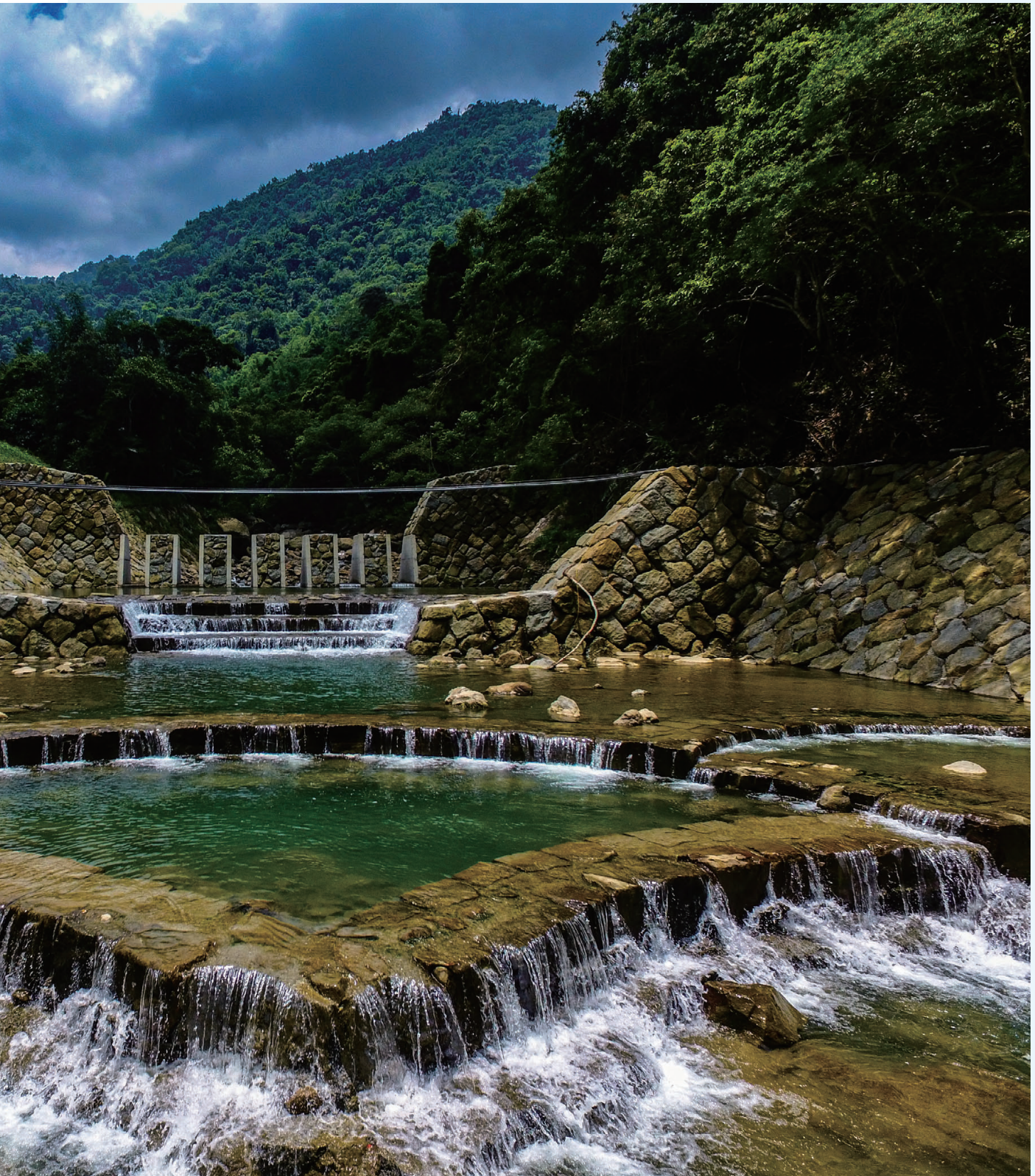
▲ 東西坑溪崩場地及野溪治理七期工程（嘉義縣大埔鄉）
