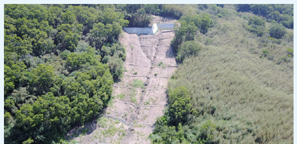
▲ 富南村電臺山崩場地整治工程(花蓮縣富里鄉)
