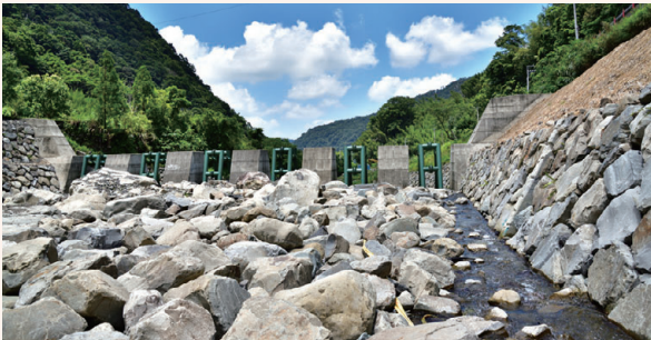
▲ 煤源二號橋上游野溪治理二期工程 (新竹縣尖石鄉)
