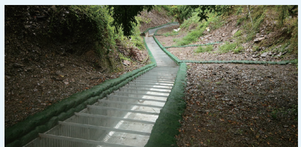
▲ 松茂地滑整體治理第一期排水工程(臺中市和平區)
