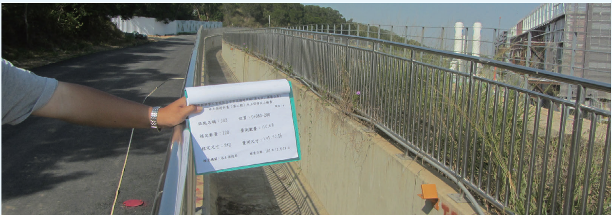
▲ 水土保持計畫施工中檢查 - 中部科學工業園區擴建用地
