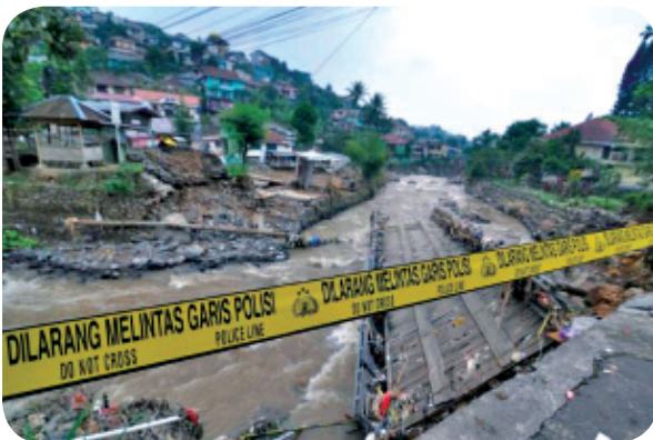
▲ 圖 6-19 土石流造成建物損毀 (圖片來源：法新社)
