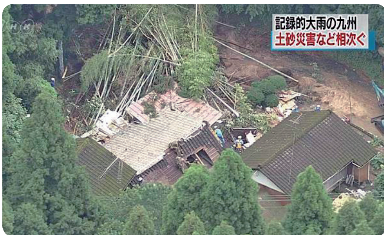
圖 6-27 大量土石沖進山腰下的民宅內，使房屋嚴重受損（圖片來源：民視新聞）
