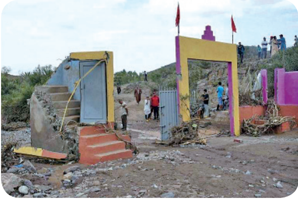
圖 6-36 土石流造成建物損毀 (圖片來源：法新社)
