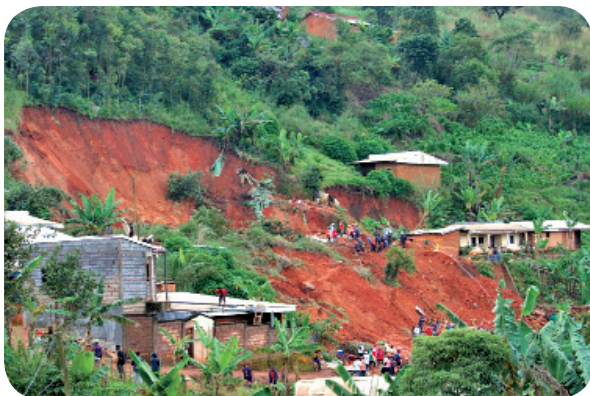
▲ 圖 6-49 土石流使大量房屋倒塌受損 （圖片來源：CRTV）
