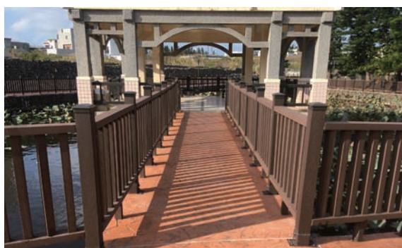
▲ 湖西鄉澎 202 線環境改善工程 (澎湖縣湖西鄉)
