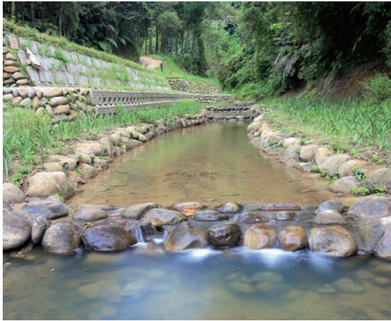
▲ 四角林野溪整治工程（臺中市東勢區）
