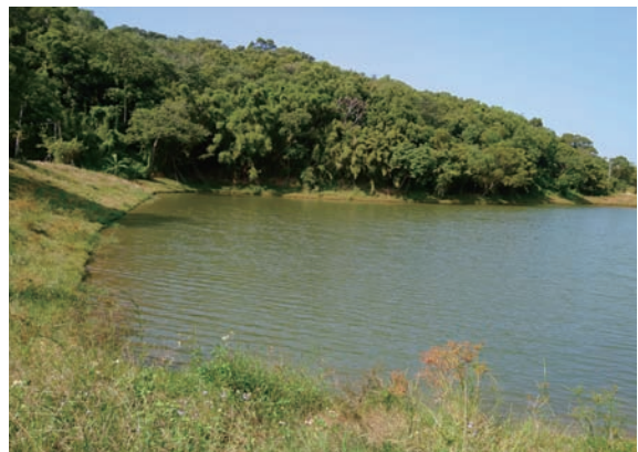
▲ 黃家埤滯洪保水設施改善工程(苗栗縣頭份鎮)
