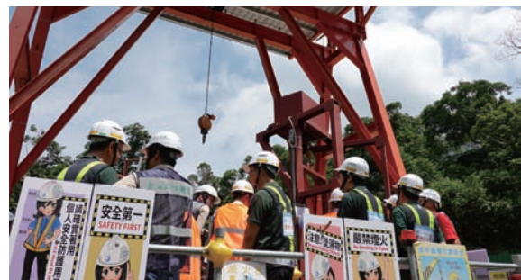
▲ 石碇大崙山整治工程（新北市石碇區）—利用主、被動監控系統及建築資訊模擬（BIM），以強化施工安全
