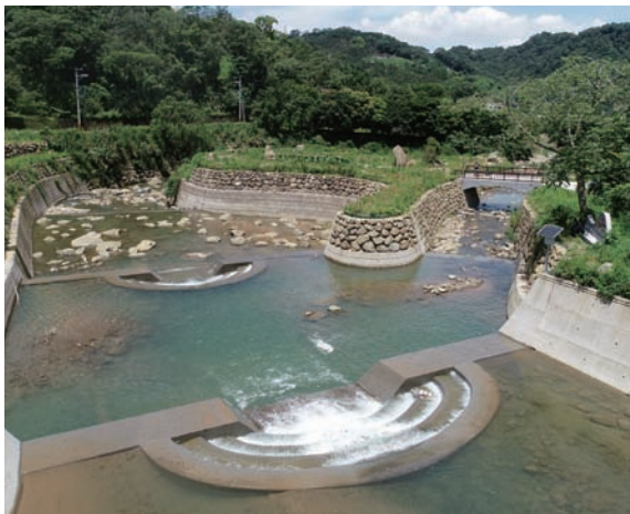
▲ 新社中和里 6-7 鄰抽藤坑溪整治工程（臺中市新社區）
