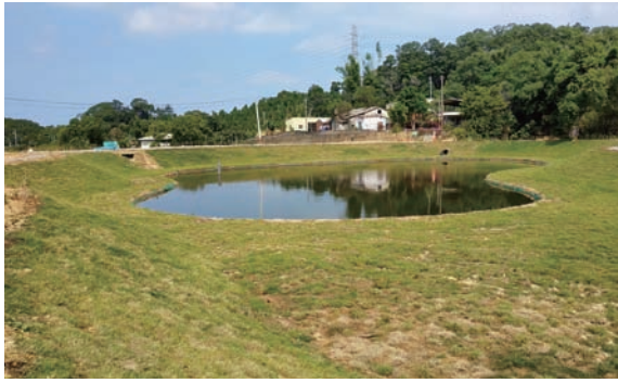
▲ 畚箕湖滯洪保水設施改善工程(苗栗縣頭份鎮)
