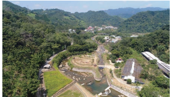
▲ 新社中和里 6-7 鄰抽藤坑溪整治工程 (臺中市新社區)
