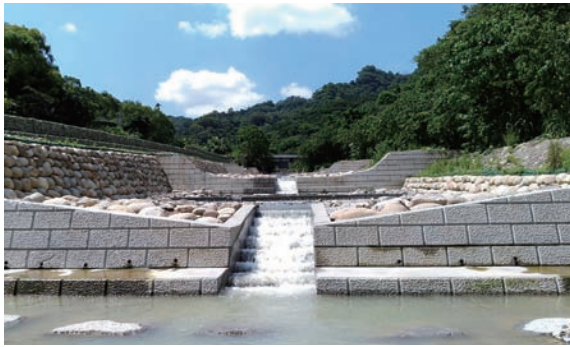
▲ 茄苳寮溪整治五期工程（臺中市新社區）
