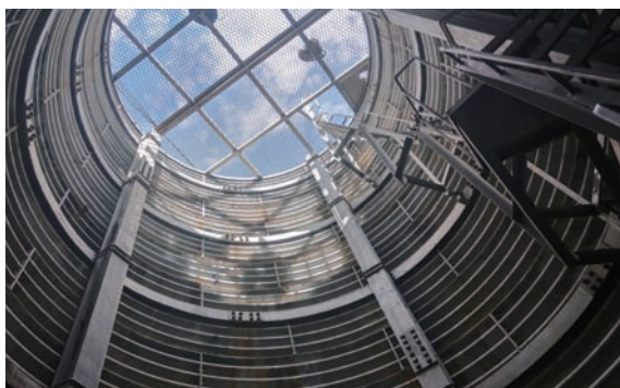
▲ 松茂地滑整體治理第一期集水井工程 (臺中市和平區)
