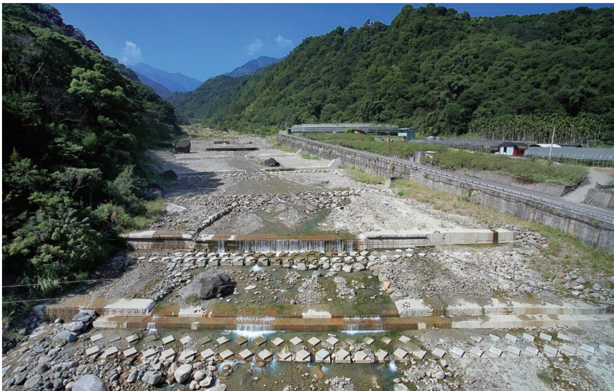
▲ 筆石橋上游野溪整治工程（南投縣信義鄉）
