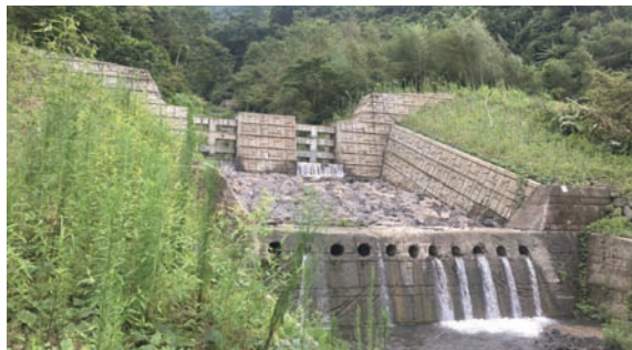
▲ 德荃橋野溪治理工程(宜蘭縣大同鄉)
