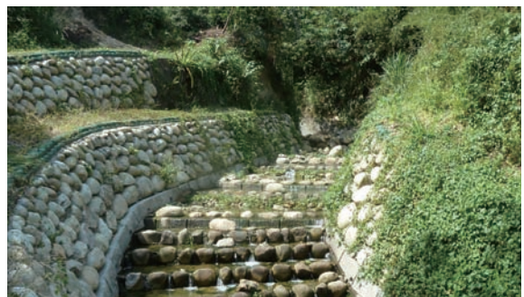
▲ 新社慶西山豬湖野溪整治二期工程 （臺中市新社區）
