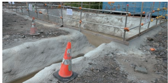
▲ 水土保持計畫施工訪查 - 臺 9 線 467K+450-468K+500 (丹路外環道) 改善工程
