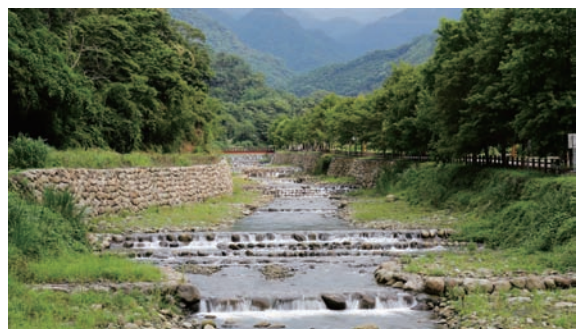
▲ 獅潭鄉大東勢溪新店四橋上游野溪整治工程 (苗栗縣獅潭鄉)
