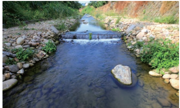
▲ 大樹區統嶺坑溪環境改善工程（高雄市大樹區）
