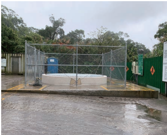
▲ 石碇大崙山整治工程(新北市石碇區)
