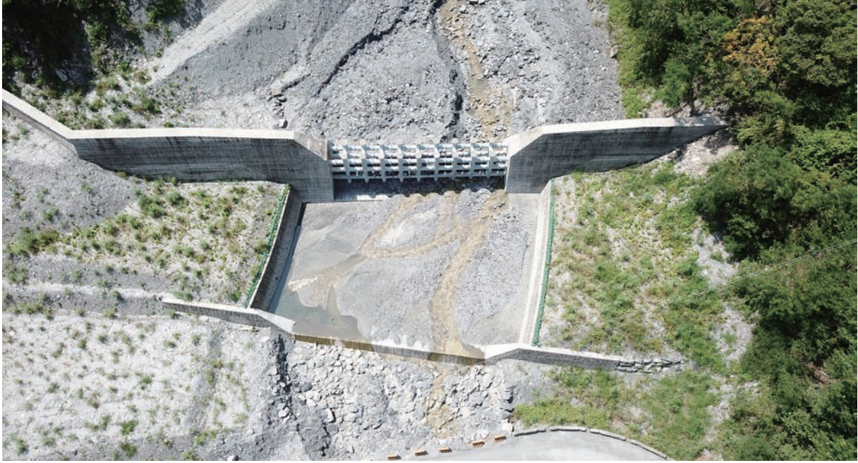
▲ 霧大二號橋上下游整治工程(屏東縣霧臺鄉)
