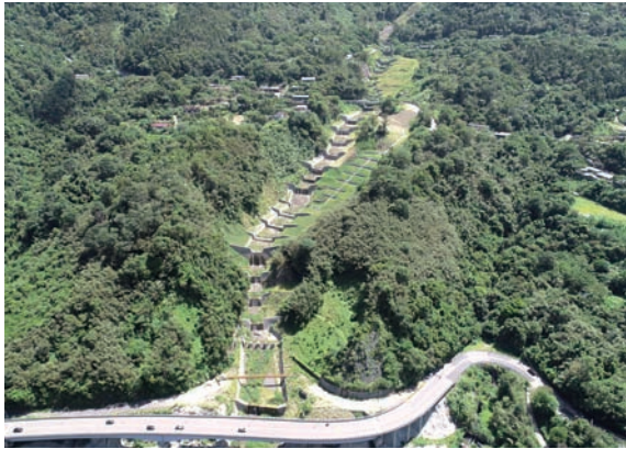
▲ 忠治二號橋下游右岸崩塌處理二期工程 (新北市烏來區)
