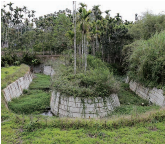
▲ 新城村 14 鄰坑溝整治工程(南投縣魚池鄉)
