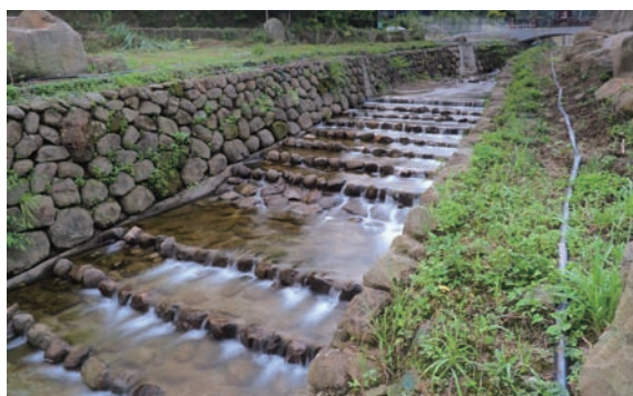
▲ 新社中和里 6-7 鄰抽藤坑溪整治工程 (臺中市新社區)
