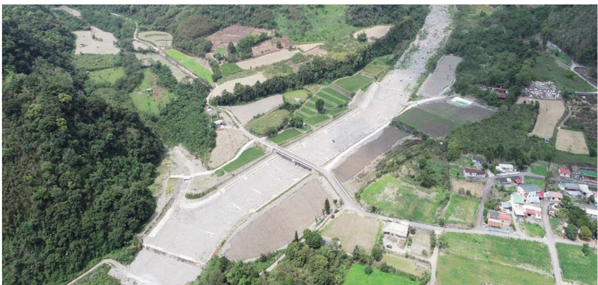
▲ 崁頂野溪中上游整治工程(臺東縣海端鄉)
