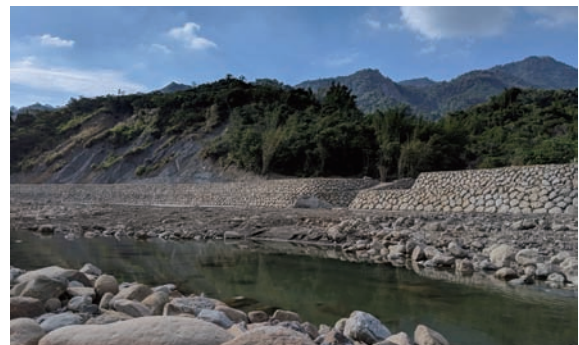
▲ 仁耀橋下游護岸整治四期工程(臺南市南化區)
