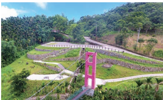
▲ 古坑鄉桂林社區行霖吊橋旁環境改善工程 (雲林縣古坑鄉)
