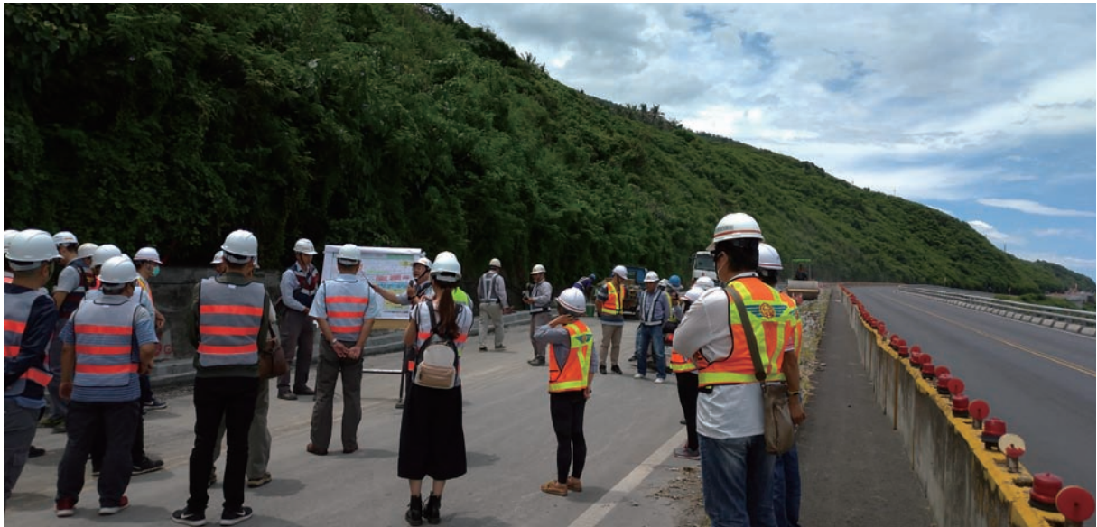
▲ 水土保持計畫施工訪查 - 交通部臺 9 線 426K+000-432K+832 拓寬改善工程訪查
