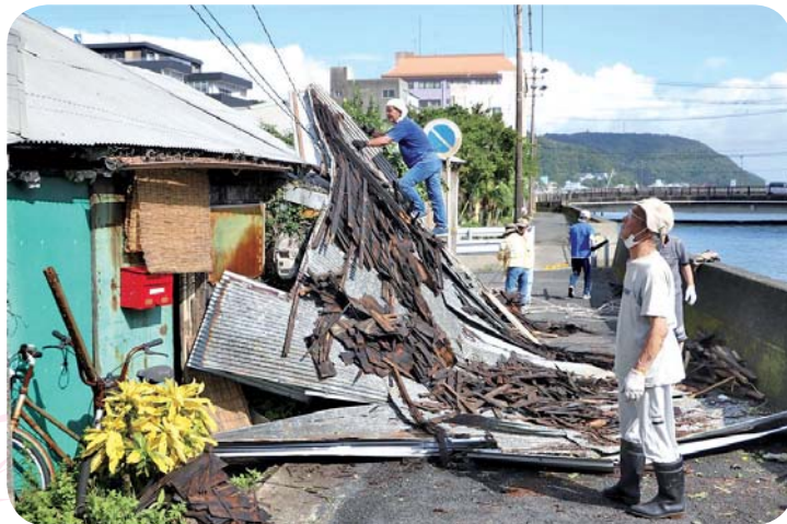
圖 6-40 九州奄美地區鐵皮屋頂被颱風吹翻（圖片來源：中央通訊社）
