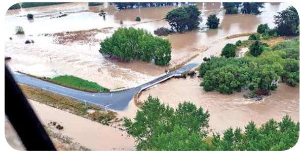
圖 6-13 洪水氾濫 （圖片來源：New Zealand Herald）
