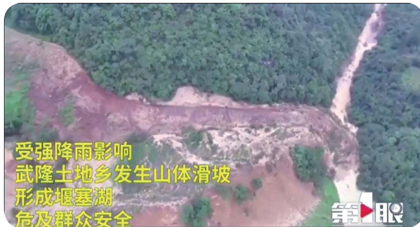
圖 6-33 崩落的土體掩蓋河道（圖片來源：蘋果即時）
