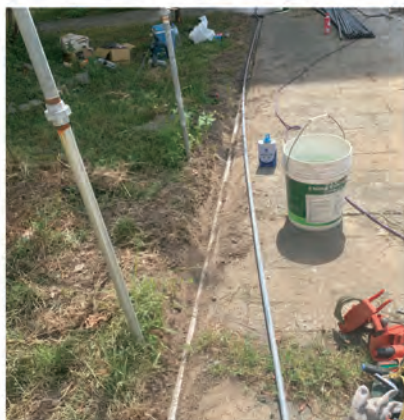
水電及暗管佈線(清江國小)
