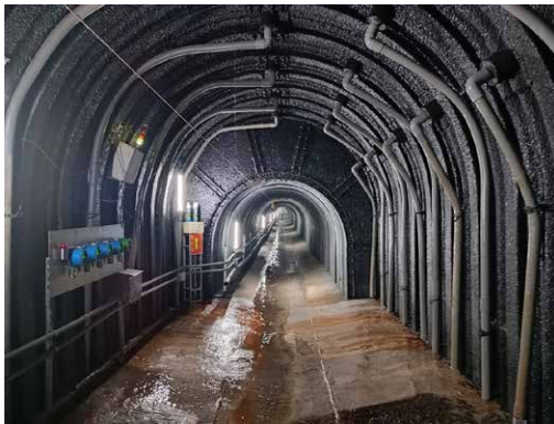
圖 3-41・G1 排水廊道除了排除深層地下水外，相關監測教育宣導、水資源利用等；排水廊道屬侷限空間，人員進出須管制，透過科技化人員識別有效的管控，達到 20 年零工安，設施維護卓越。
