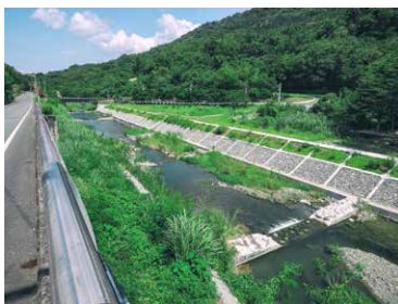
圖 3-32 · 於坡趾施作連續固床工穩定坡面基礎，提升坡面整體穩定性。
