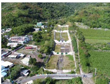
圖 3-55・以採可調式鋼構工程改善延長壩體壽命。
