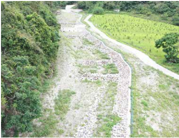
圖 3-33・以鋼構壩及護岸穩定河床，大幅減少兩岸土石的流失。
