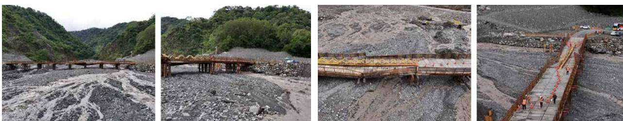
圖 1-23 · 112 年 8 月 9 日以無人載具空拍明霸克露橋側拍影像
