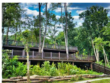
圖 3-38・新化區新化林場友善里山環境場域改善工程，雙階平台保留既有大樹提供多功能使用。
