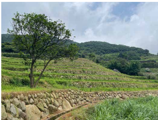
圖 3-64 · 石門區嵩山社區水梯田復育工程營造特色產業地景，景色美不勝收。
