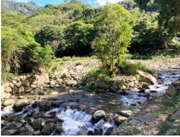
圖 3-25・此工程保留既有樹島並於邊坡砌石保護，防止樹島土壤流失，不但減少大量開挖及對環境影響，更保護樹島上多樣化動植物及棲地。
