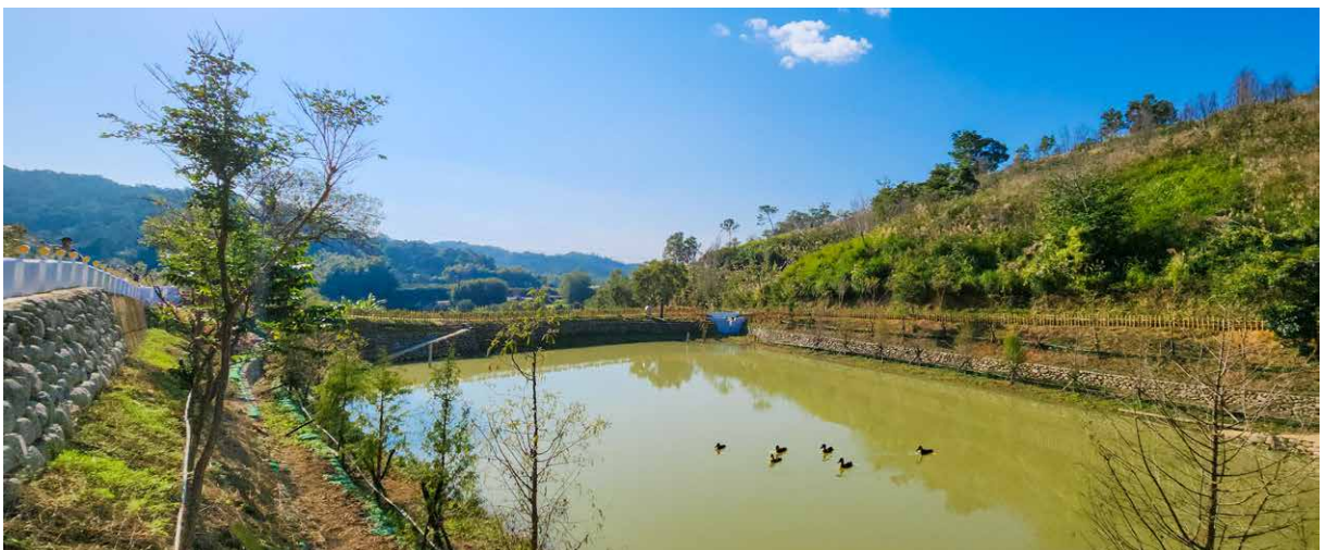
圖 1-5・苗栗縣頭份市文正段 255 地號滯洪農塘改善工程
