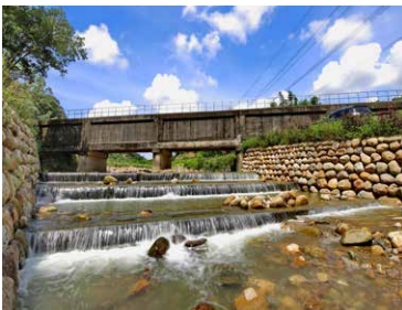
圖 3-49・研發專利預鑄塊設計護岸施作曲線優美、多樣化生態友善設施、低水流路設計維持生態基流量，豐富其生態環境。
