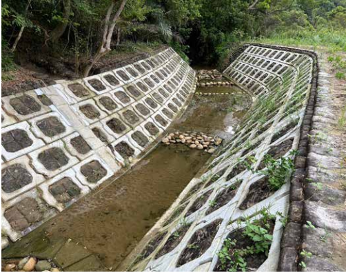
圖 3-61・植生槽預鑄護岸，1 比 1 緩坡護岸打造全面性生物通道，非渠道化設計師法自然。
