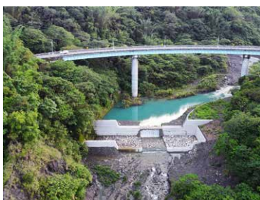
圖 3-31 · 建山一號橋上游打鐵坑野溪整治工程 - 拆卸式改良式透過性鋼格壩，可彈性調節土砂量。
