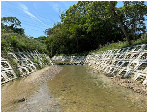
圖 3-63・預鑄式護岸可以促進植物的根系和微生物吸收，同時分解水體中的有害物質，提高水質的淨化效果。
