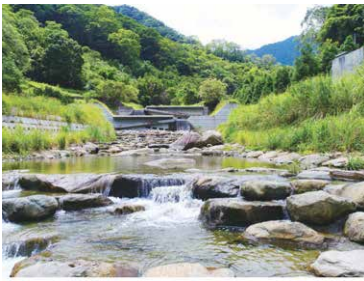
圖 3-26・維護野溪縱向生態廊道暢通，同時保護既有深潭內魚類生態，減輕施工時對當地生態環境之衝擊。
