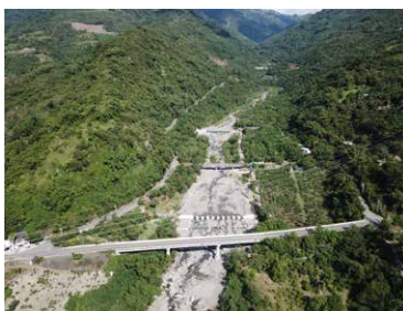
圖 3-54・因土砂大量下移，工程以韌性平衡砂為首要工作，以延長工程壽命並考量生態友善措施。
