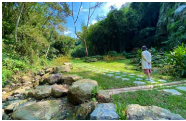
圖 3-67・入口處以緩坡化的乾砌石打造自然的生態通道
