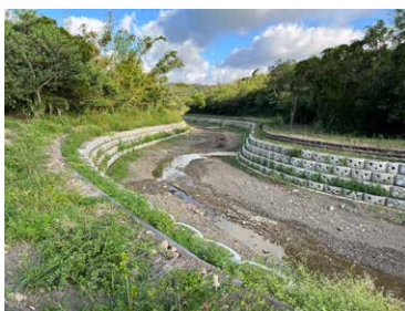
圖 3-53・構件組立順應自然，河道完成面曲線優美。
