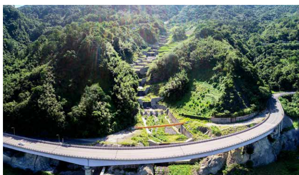
圖 3-20・工程完工後有效保全臺 9 甲通行安全，避免烏來成為孤島。
