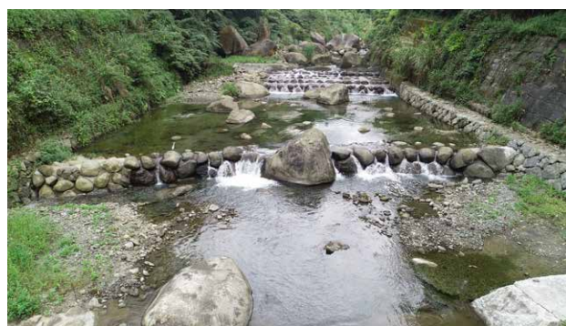
圖 3-21・透過天然砌石、GRC 工法等改善鹿谷和雅橋上下游固床工，友善野溪棲地環境，並兼顧防災功能。
