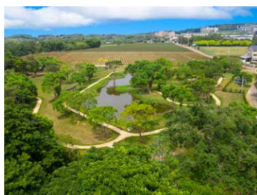
圖 3-40・此工程將廢木遍地的荒地重整為蓄水滯洪池農塘，成為可穩定灌溉、支持周邊茶園復耕的重要後援。
