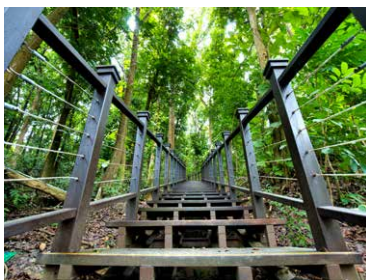
圖 3-47・林間木棧道以手持鑽掘樁施作減低擾動及迴避大樹
