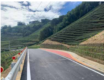
圖 3-50・農路設施改善後，路人行車環境更安全，同時也增進農作運輸及在地觀光效益。
