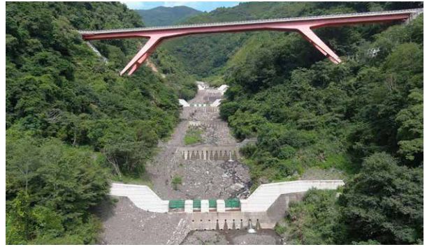
圖 1-3・桃園市復興區蘇樂野溪囚砂設施治理工程
