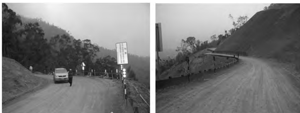
圖 9 莫拉克風災後藤枝林道緊急搶通路基施作狀況
