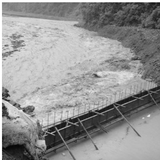
圖 4 拆除重建的擋土牆（護岸）
