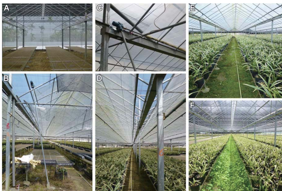
圖一、捲揚防雨設施重要元件(A、B、C、D)與其栽培小花蕙蘭之情形(E、F)；A：具透光塑膠布捲軸捲起之情形；B：a-外遮光網、b-內遮光網、c-怠速馬達支撐桿；C：怠速馬達；D：集雨水槽；E：透光塑膠布放下具有防雨功能之栽培情形；F：透光塑膠布捲起呈現遮光網栽培之情形
