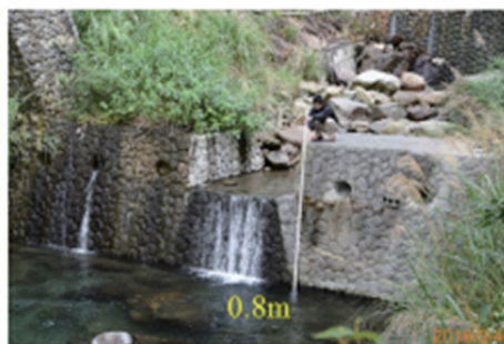
照片 1 水墊工程 Pic.1 Water cushion
