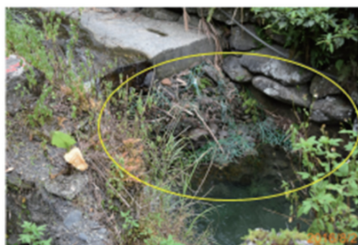
小礮溪二支流及冷水坑 野溪設施補強維護工程
