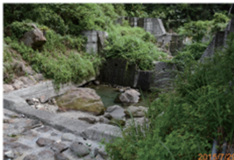
南澳北溪災害防治二期工程(柑子坑)
