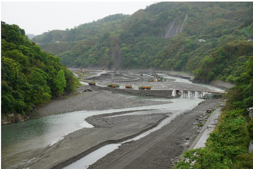
圖 4 石門水庫上游羅浮清淤作業 (2015.3.26)
