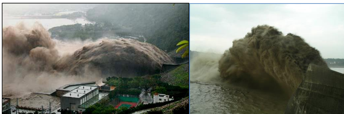
圖 2 石門水庫艾利颱風尖峰流量 8,594\text{m}^3/\text{s} ，為建庫以來第 2 大，溢洪道及排洪隧道均排放高濃度渾水層。
