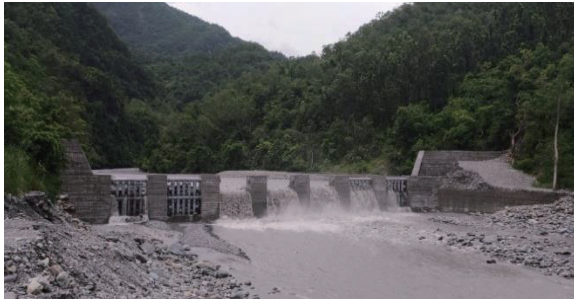
圖 3.知本溪之調節式防砂壩全貌
