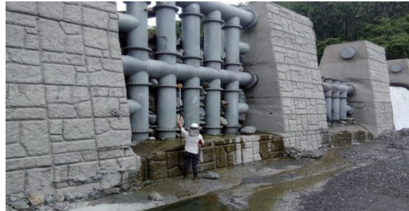
圖 4.知本溪之調節式防砂壩淤積情形
