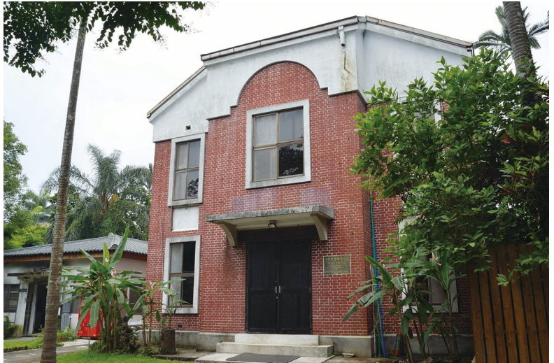
圖五、臘葉館修復前建築外觀（林業試驗所提供）
