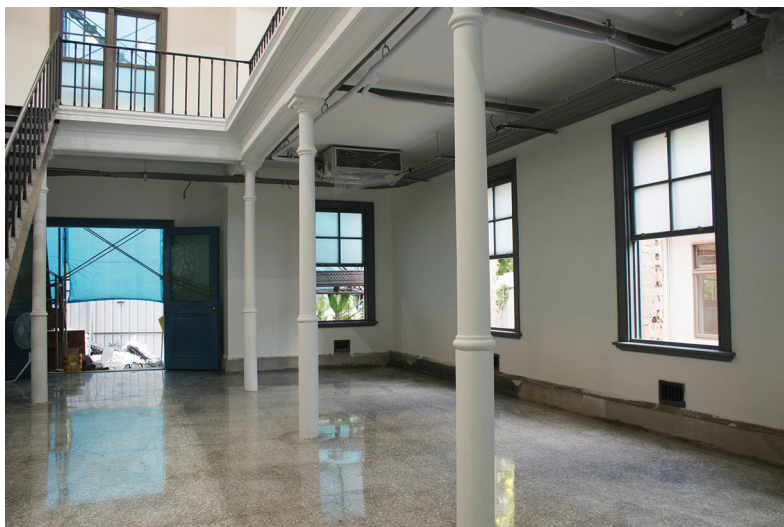
圖七、拆除增建磚牆後，修復露出之羅馬立柱
