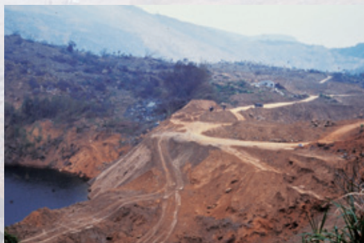
921地震後九份二山地區崩塌堆積區
