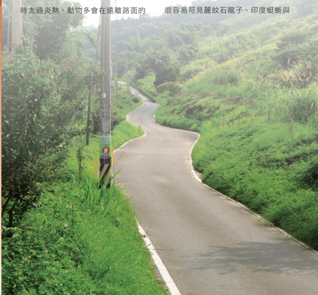
龍南道路貫穿崩塌地
