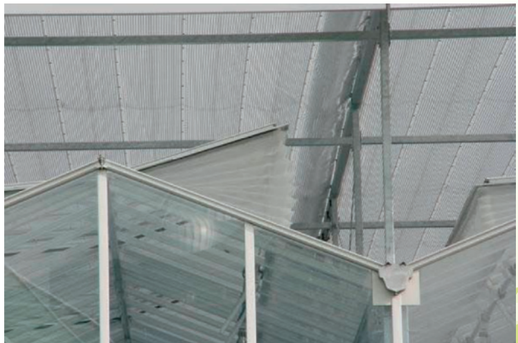
圖4.11 在天窗開口的防蟲網，結合有外遮陰網
