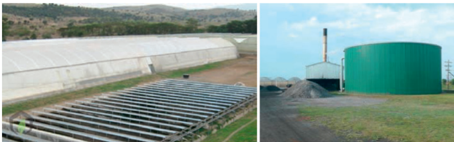
圖4.23 用於溫室加熱系統之集熱器 (左圖, www.certhon.com) 及熱能儲存桶 (右圖)
