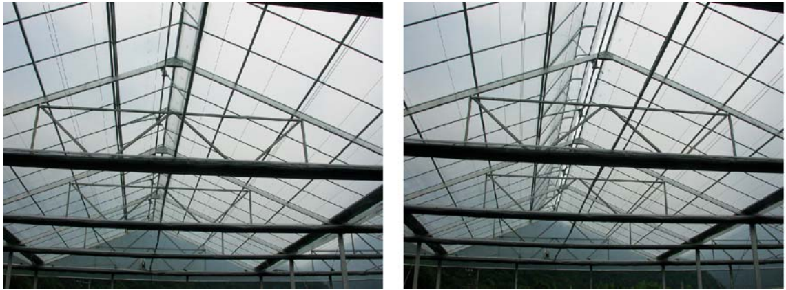
圖3.山型塑膠布鋁管連棟溫室，有3個屋脊中間的一個用馬達開閉。（南投縣仁愛鄉的小品盆花栽培場）
