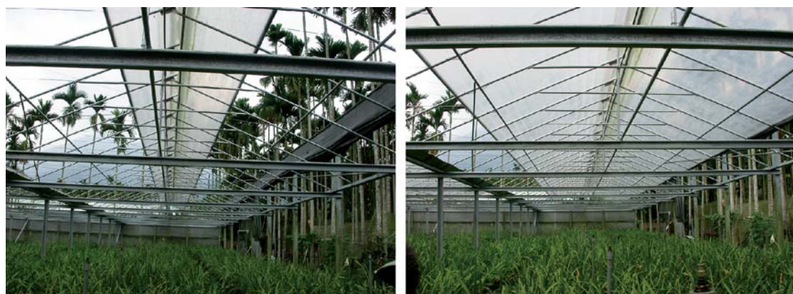
圖12.山型連棟溫室屋頂覆蓋捲揚式塑膠布的展開過程。南投縣的虎頭蘭栽培場。
