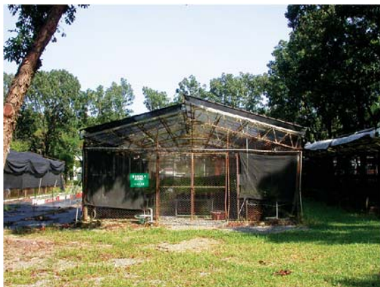
圖10.力霸鋼架構的山型高低落差屋脊設施，屋頂有遮光網用的簡易鐵架；位於屏東科技大學校園。
