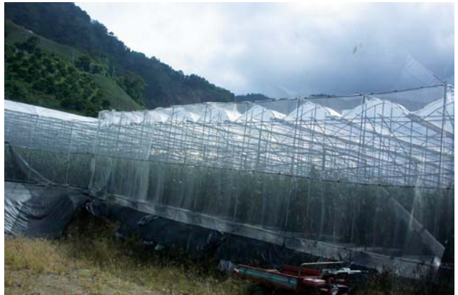
圖7.南投縣信義鄉栽種番茄和青椒的小跨距拱型連棟溫室，拱型之間是開放通風口。
