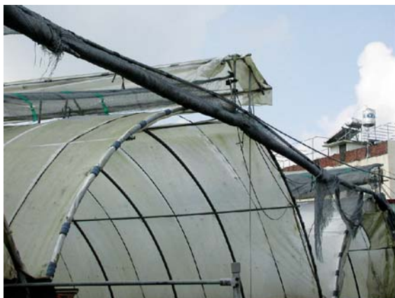
圖8.塑膠布鉸管架構拱型太子樓溫室，高雄地區切花玫瑰用設施。
