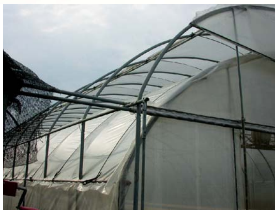
圖9.新竹香山水耕場的雙層拱型鋁管塑膠布溫室。
