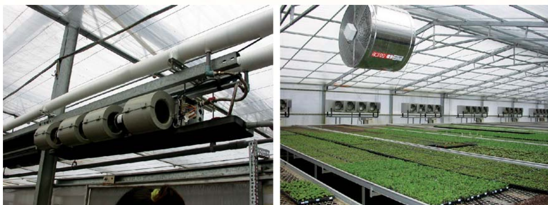
圖15. (左)蝴蝶蘭低溫催花房的冰水管和送風機(一心蘭園, 2009)。(右)洋桔梗幼苗的15 °C 低溫春化處理冷房(松賀園藝, 2010)。兩者均用雙層塑膠膜隔熱。
