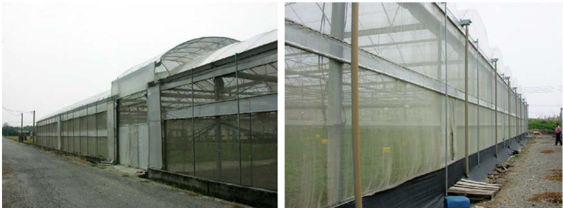
圖14.拱型塑膠布鋁管連棟溫室，周圍設防蟲網和捲揚式塑膠幕，左圖中間較高的屋頂是散熱口；裡面用內循環風扇促進空氣流動。（雲林虎尾花卉產銷班）
