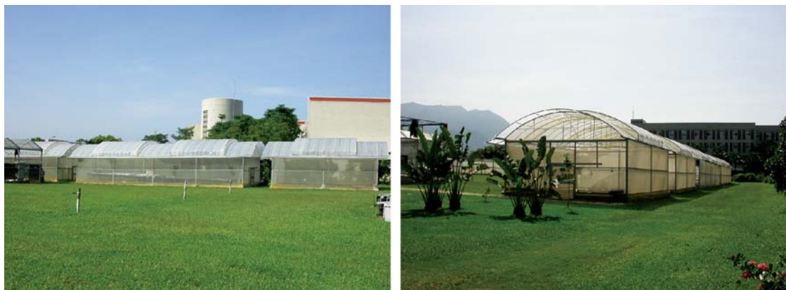
圖11.高底拱型屋頂鉸管塑膠布溫室，位於屏東科技大學校永續農業研究農場。溫室的兩端一定是低屋頂。
