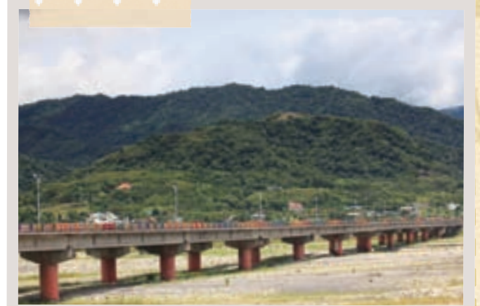
橫跨在花東縱谷上的玉里大橋，是全臺唯一會「長高」的橋樑。這是因為玉里大橋位在歐亞板塊和菲律賓海板塊接合處，在板塊相互推擠之下，橋墩也隨著「長高」。從建橋至今的三十多年來，已長高 56 公分。
