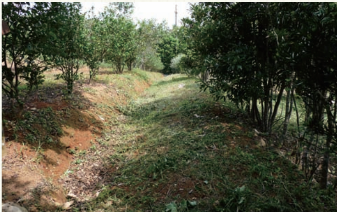
在坡地上每隔適當距離挖一條山邊溝，可減短坡長，防止水土沖蝕，還可以當成田間作業的道路。
