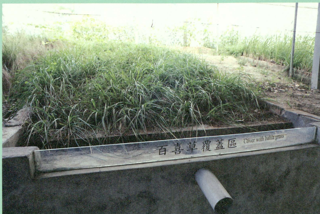
百喜草，可以栽植於道路邊坡，綠化、保護坡面，甚至可栽植於排水溝面以取代水泥、塊石等材料
