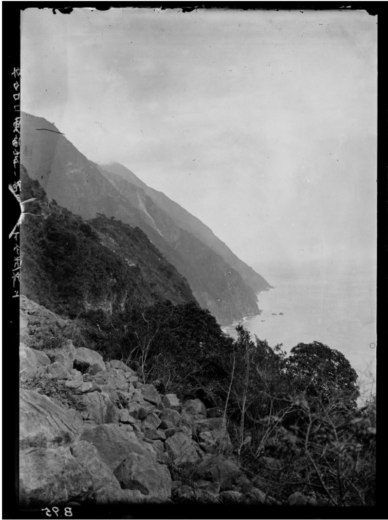
花蓮港廳外タロコ東海岸の絶壁、坂下分遺所の上
