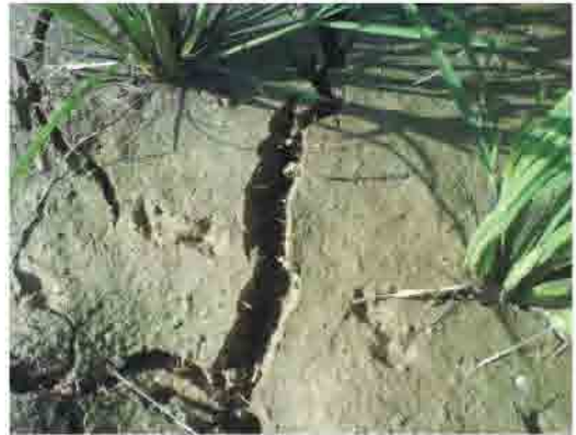
曬田至土面龜裂，裂縫可容指頭塞入即可
