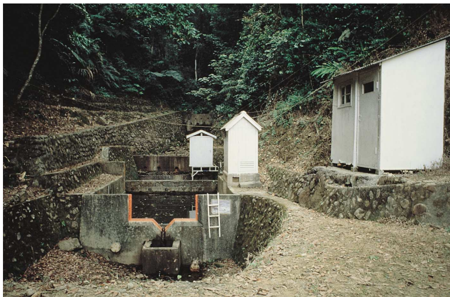
圖 13. 林試所蓮華池分所 3 號集水區量水堰圖
