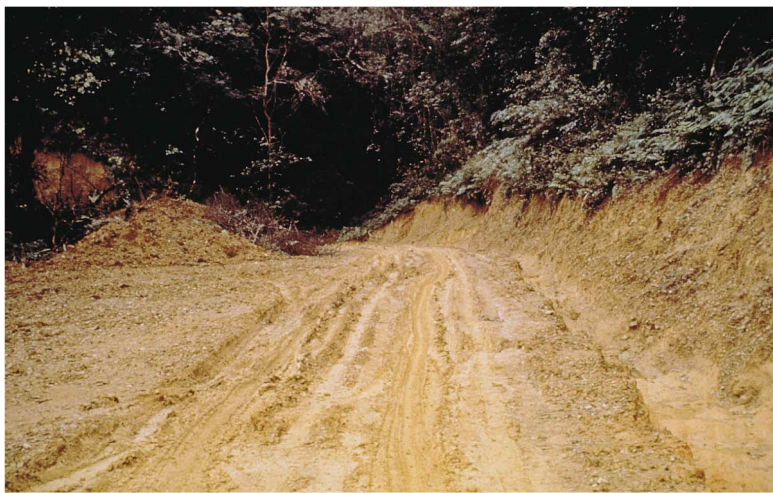
圖 33. 林道路面上的地表逕流
