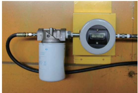
圖 6-4-3、電子式柴油流量計
