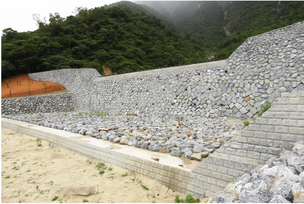
圖 2-3 砌塊石壩面塊石混凝土填心壩
