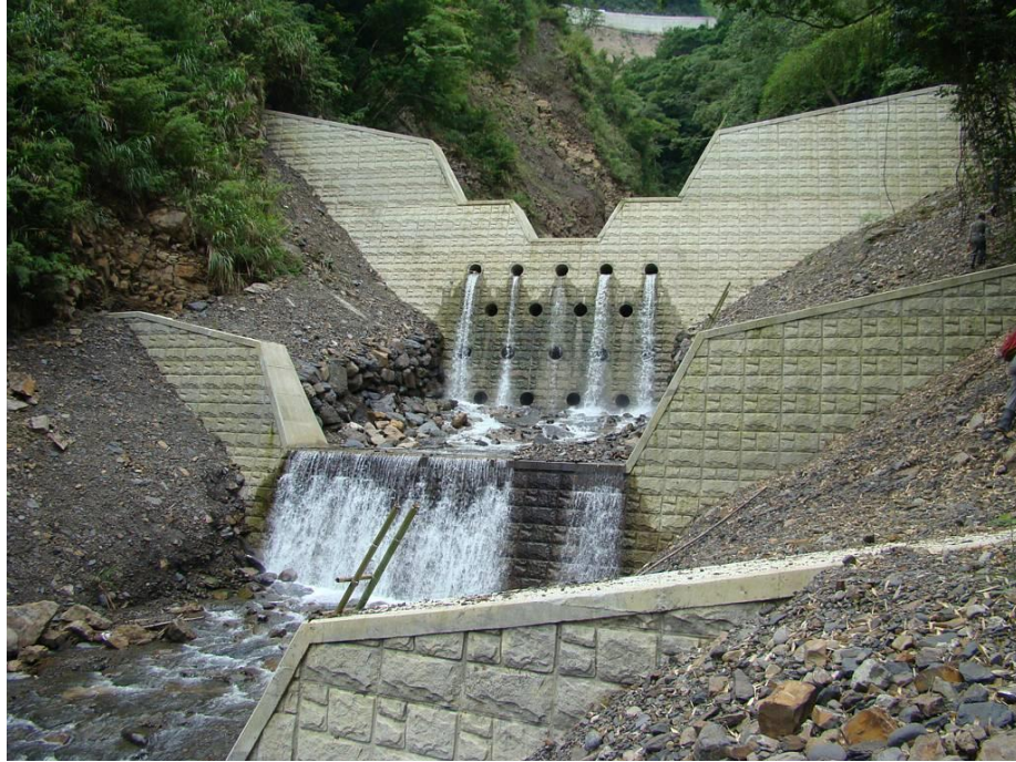
圖 2-6 混凝土重力式防砂壩現場照片
