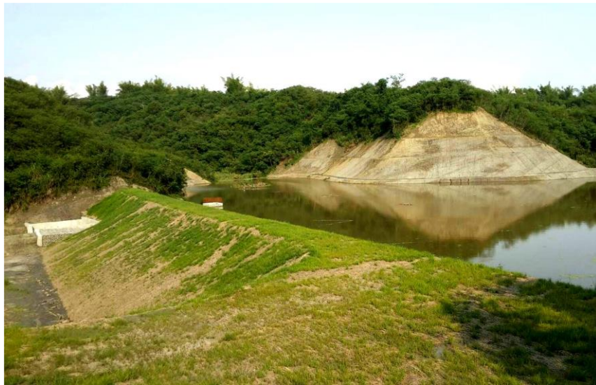
圖 2-10 土壩採用豎井溢洪道之照片
