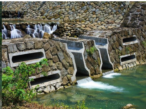
圖片來源：行政院農業委員會水土保持局- 東西坑溪崩塌地及野溪治理五期工程
