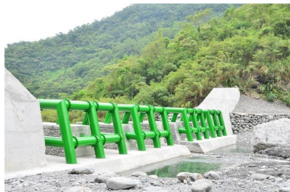
圖 2-4 混凝土鋼構梳子壩示意圖
