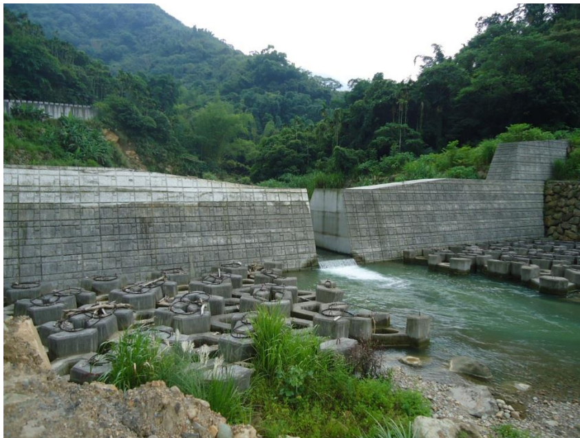
圖 4-2 粗坑吊橋上游野溪整治工程之防砂壩
