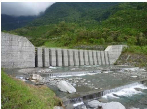
圖 2-4 混凝土鋼構梳子壩示意圖
