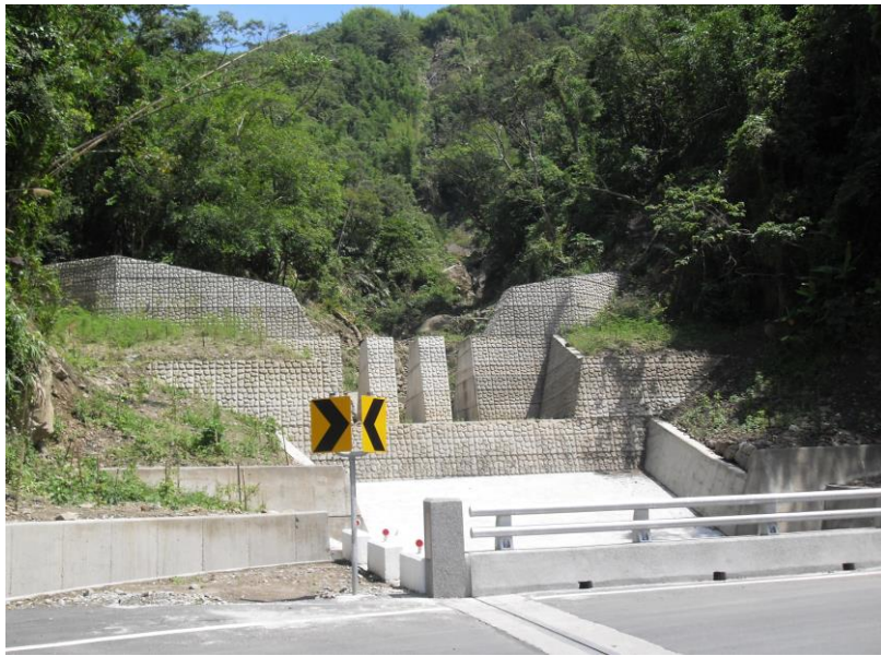
圖 4-12 山美 2 鄰野溪災害復建工程之梳子壩
