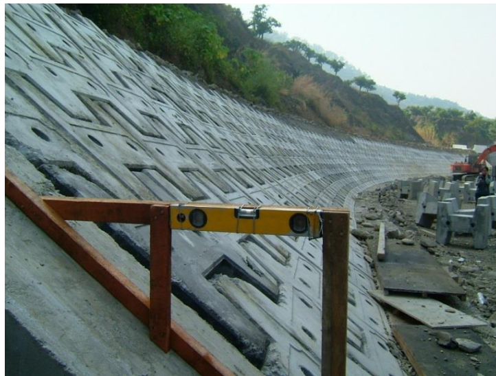
照片 6 護岸坡度檢驗
