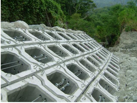
(a)羊橋四期整溪整治工程
