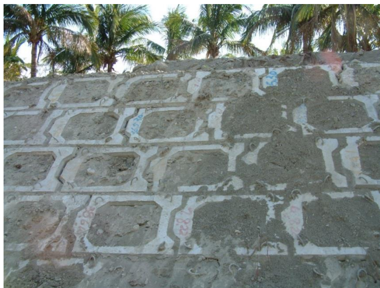
照片 5-6 RC 箱回填土壤
