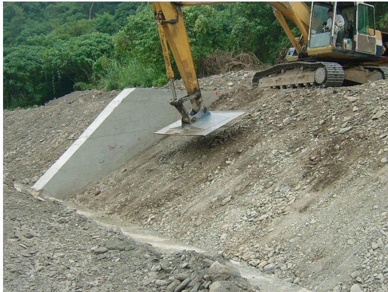
照片 2 溪流岸坡整坡
