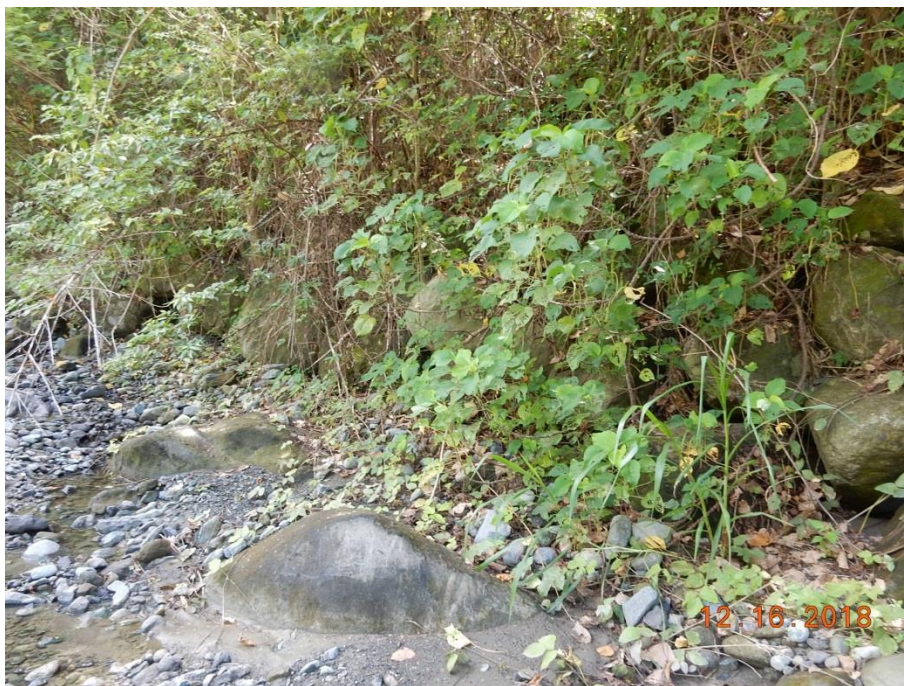
照片 5-9 低水護岸穩定現況
