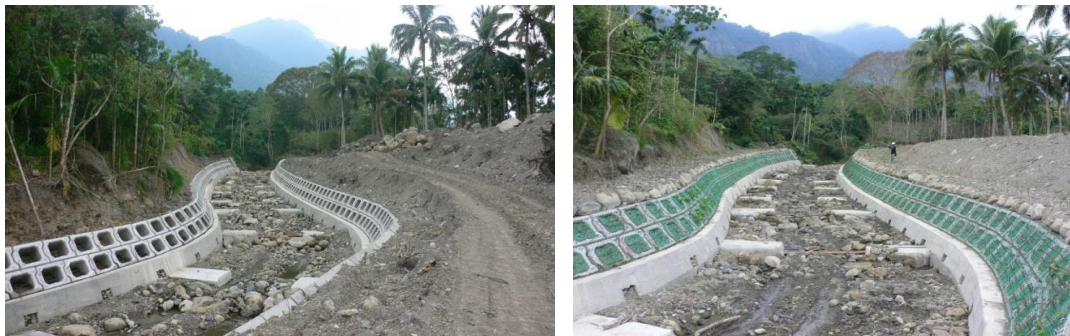
照片 16 RC 箱塊蓆式鋪設組立
