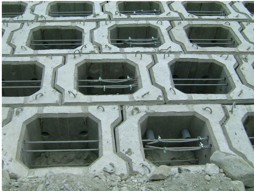
照片 5-4 RC 箱鋼索扣接方式
