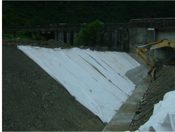
照片 3 鋪設濾層
