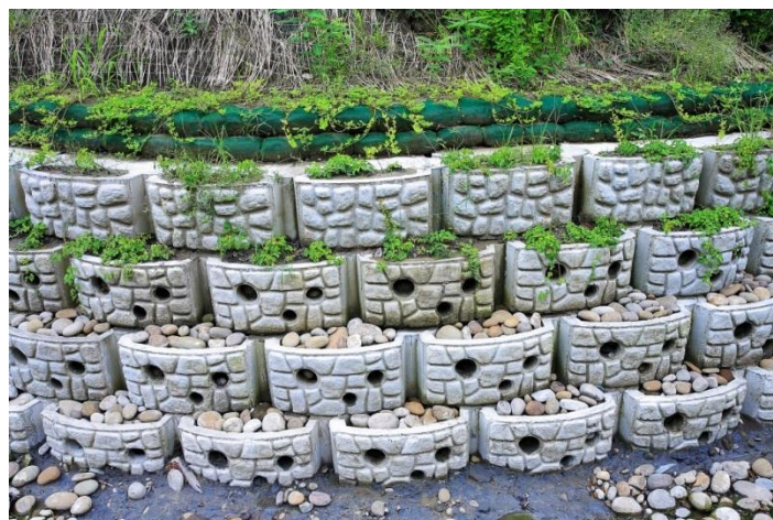
照片 10 完工照片
