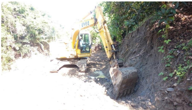
照片 8 溪流岸坡整坡
