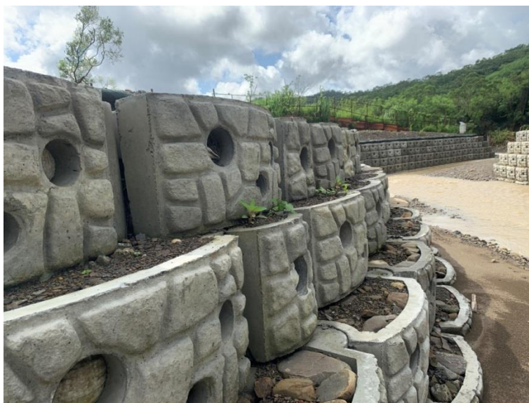
圖 3-7 預鑄塊內回填土方及卵礫石
