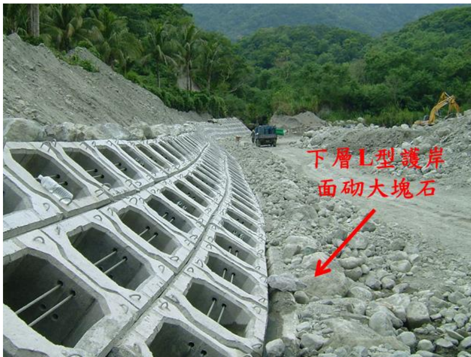
(a) 施工中低水位護岸
