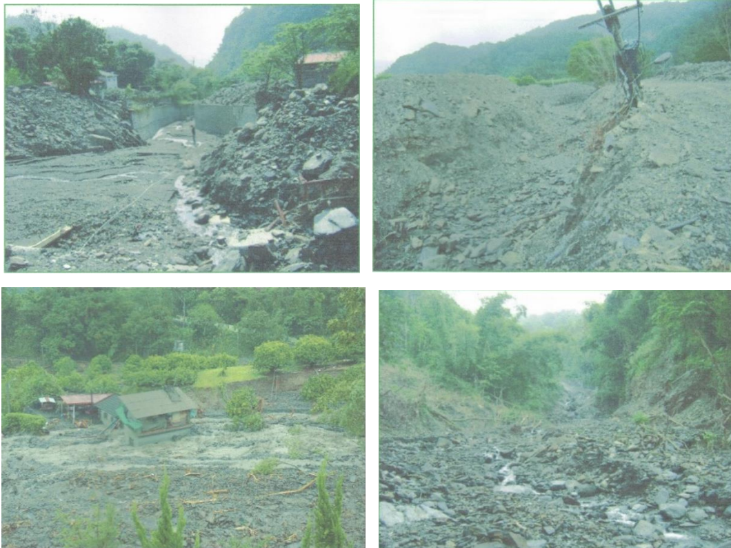
照片 5-10 舊潭 2 號橋野溪土砂災害現況
