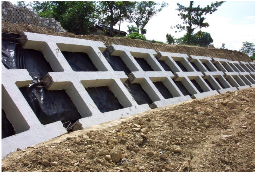
圖 3-4 預鑄護岸土工織物濾層
