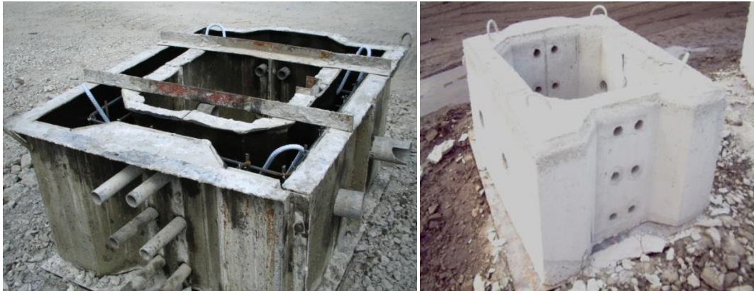
照片 15 金屬模組立與配筋及預鑄完成後外觀
