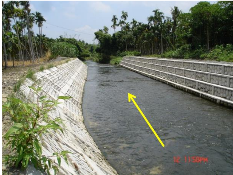
圖 3-9 平面鋪蓆型(左岸)與分層疊砌型(右岸)預鑄護岸
