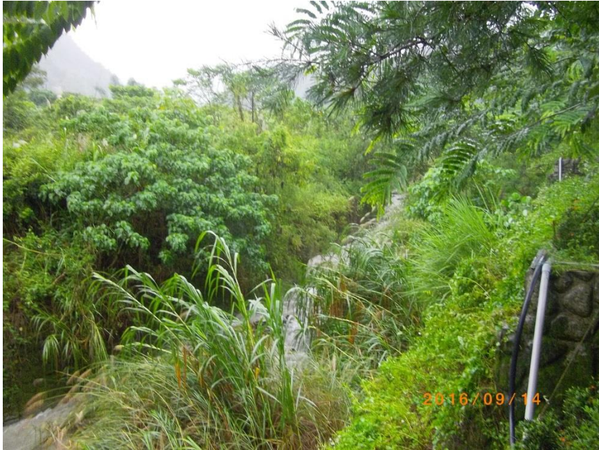
照片 5-14 護岸穩定現況
