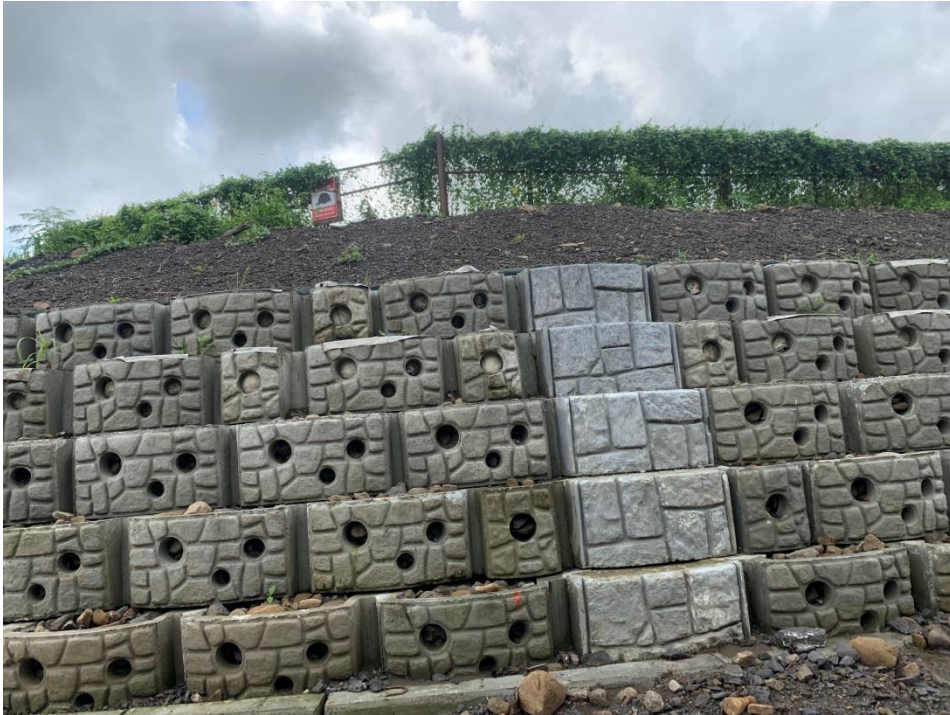
圖 3-6 預鑄護岸預鑄塊體錯縫排列(臺南分局出火野溪整治工程)
