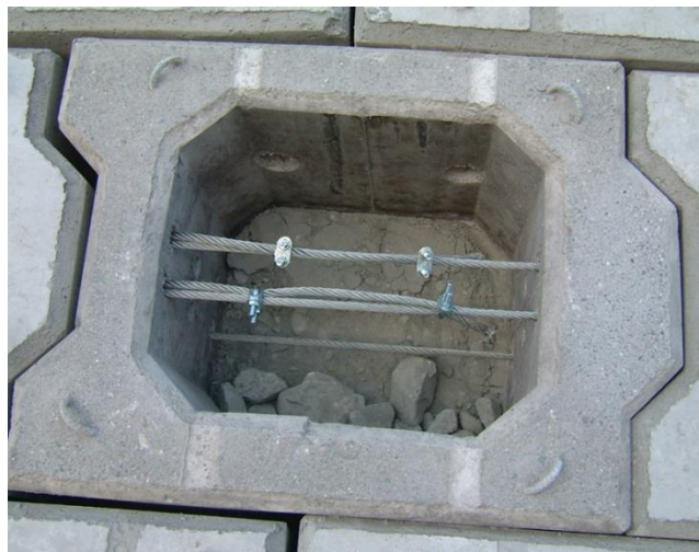
照片 4-1 預鑄塊體以鋼纜聯接
