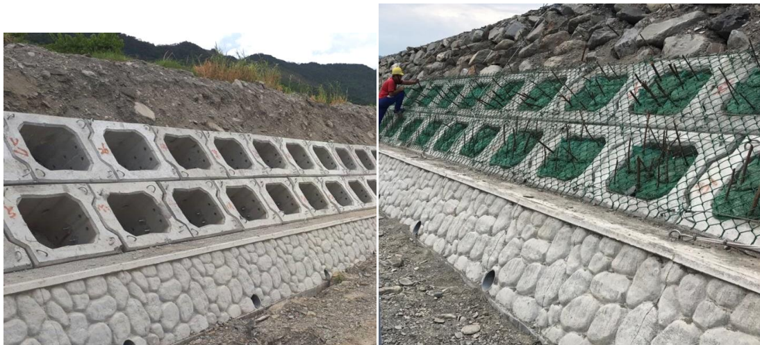
照片 14 鋪設 RC 箱塊
