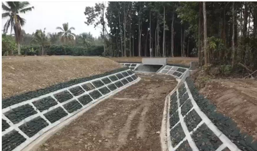
圖 3-3 凹岸處設置系列固床工
