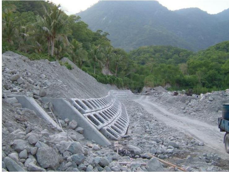
照片 5-5 護岸隔牆
