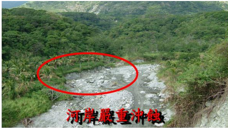
照片 5-1 羊橋溪溪流災害實況
