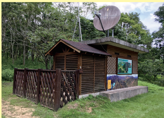
土石流觀測站，有固定式的建築物體，亦有與移動式車體，都能即時回傳當地影像資料。
